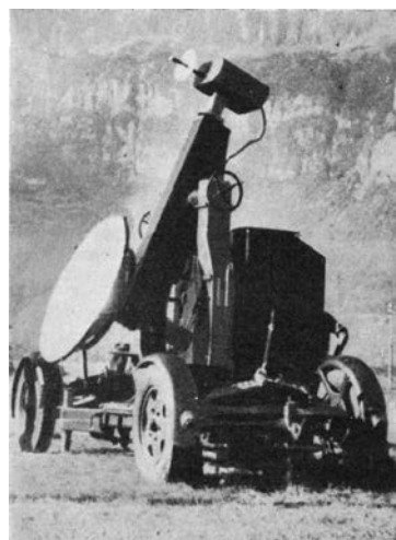
Kuva 4. Oerlikon raketin sädeoh- jauslaitteen maa-asema. Alhaalla ohjaussäteen heijastava peili ja ylhäällä maalia seuraavan pienen tutkan antenni.
