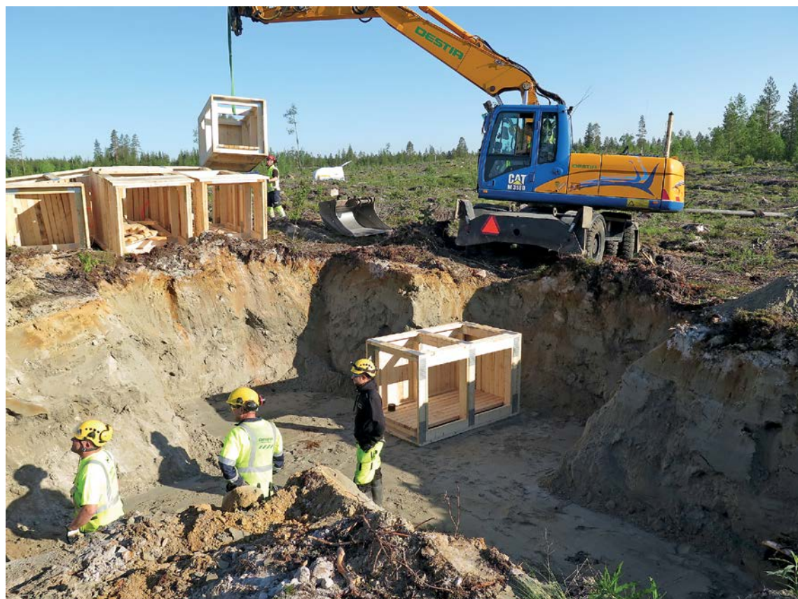
Linnoitteiden rakentamista puukehikoista SUOJA16-harjoituksessa
