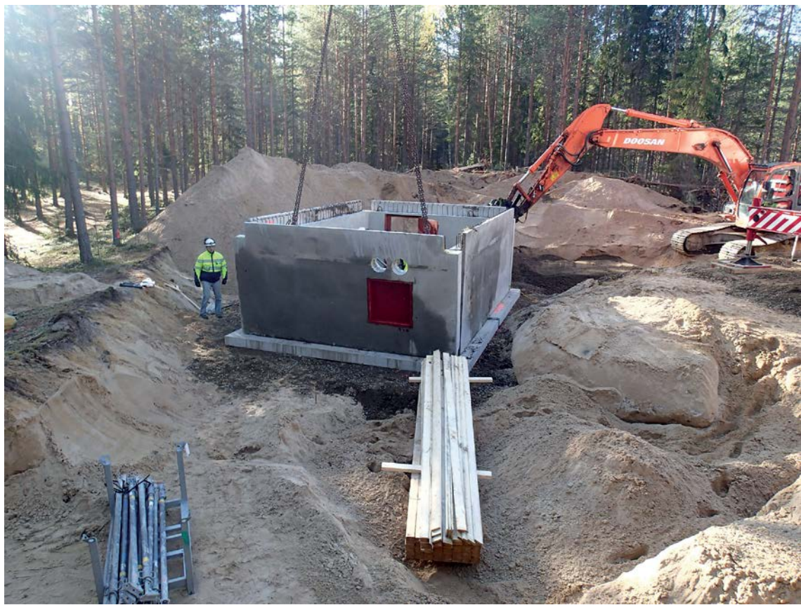
Komentopaikkaa rakennetaan betonielementeistä SUOJA16-harjoituksessa
