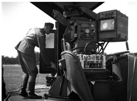
Tulenjohtotutka Würzburg D (”Irja”) oli ilmatorjuntatykistön modernin laite jatkosodassa. Kuvassa ”RATA”-patterin tutkaa tarkistetaan Santahaminassa keväällä 1943.
