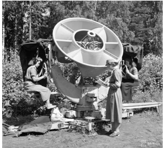
Jatkosodan lopulla Suomessa koulutettiin lottia kuulosuuntimien ja valonheittimien käyttäjiksi. Kuvassa saksalainen m/42 RRH -kuulosuunnin.
