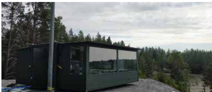
Uusi lennätyskontti mahdollistaa valmistuttuaan neljän koneen parven turvallisen ja tehokkaan lennättämisen. (Kuva: Puolustusvoimat)
