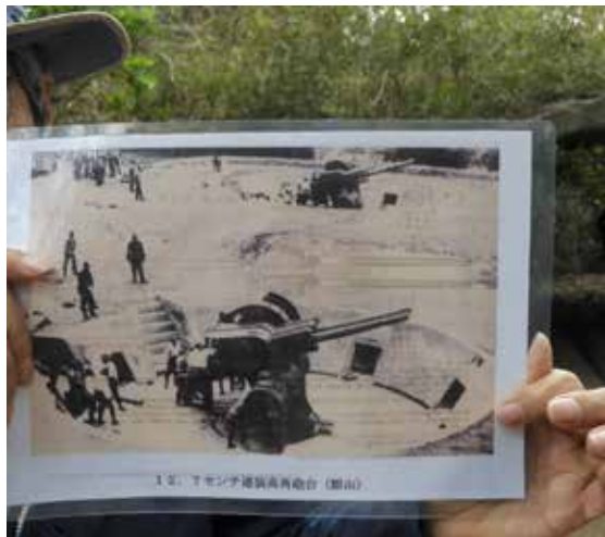
Näitä 127 mm:n moottoriohjattuja tykkejä on ollut saarella useita. Tykki on ollut alun perin tarkoitettu laivakäyttöön.
