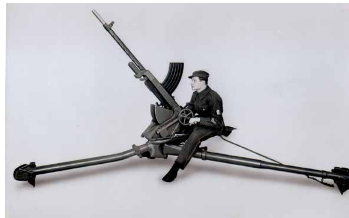
Konetykki maalavetin päällä. Kuva oli mm. Tampella esitteessä vuodelta 1939, jossa teknikko Vesa Metsola oli poseeraamassa aseiden kahvoissa. Kannattaa huomata, että vaikka aseella ollaan ampuvinaan ilmatorjuntaa, siinä ei ole it-tähtäimiä.
