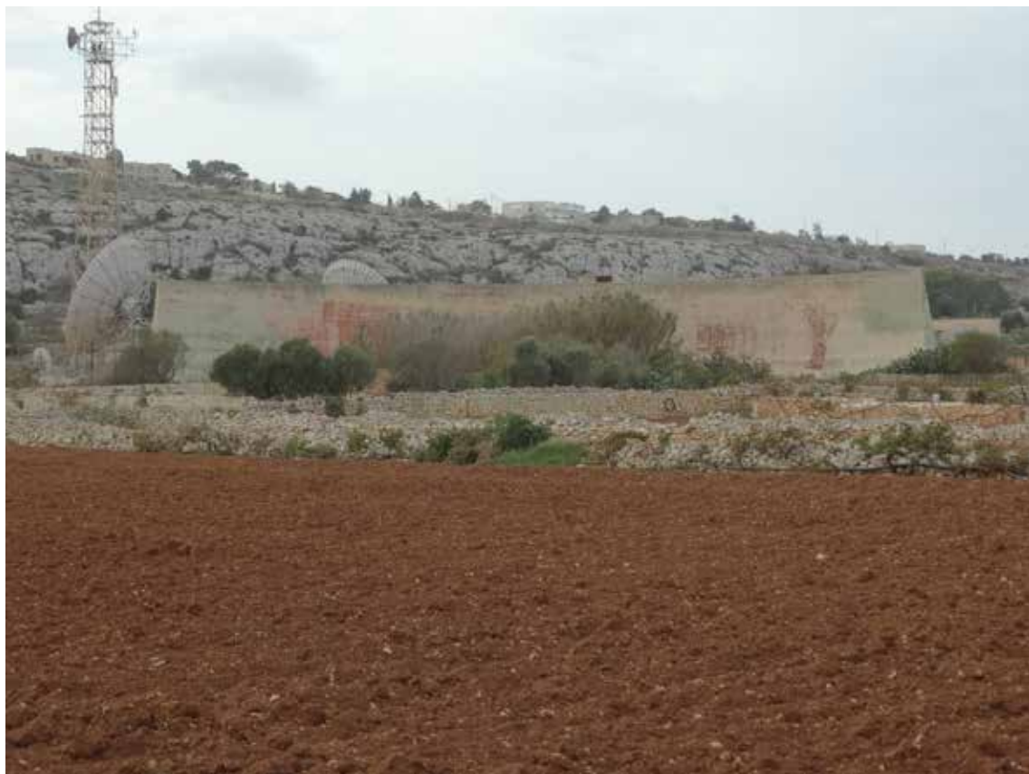
Pensaan takana oleva Maltan kaareva peili on 70 metriä leveä ja 5 metriä korkea seinä. Alueella on nyt myös tietoliikkeyhtiön satelliittiantenneja.
