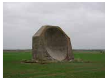
Ensimmäisen maailmansodan aikainen kuulosuunnin. Betonisen peilin läpimitta on 4,5 metriä. Edessä olevan putken päässä on paikka mikrofoniin. Paikka on Kilnsea Grange, East Yorkshire, Iso-Britannia (Kuvälähde: Wikipedia). polttopisteissä. Kaikki nämä laitteet
