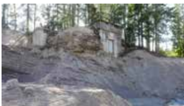
VSS-keskus kuvattuna 25.5.2019 Tykkitorninmäen koillisrinteessä rakennustyömaan reunalla. Kuva Heikki Simola
