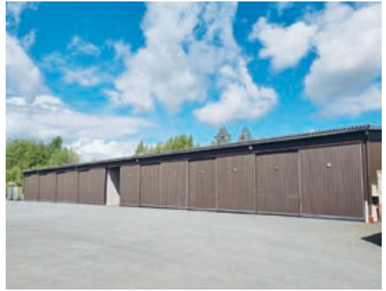
Kylmä varastohalli, rakennus 217. (Kuva: Mika Eteläsaari)
