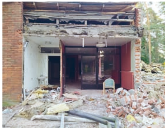
Hyrylän sotilaskotirakennus ehti olla pystyssä 60 vuotta ennen purkamista. (Kuvat: Elina Sarin)
