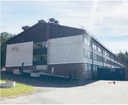
Helsingin ilmatorjuntarykmentin kasarmirakennus peruskorjauksen kohteena vuonna 2022 (Kuva: Santeri Tuominen).
