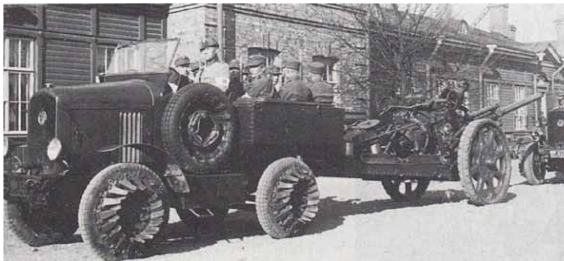
Latil KTL -traktorin vetämä 76 mm:n Bofors-tykki lähdössä paraatiin Viipurissa 16.5.1938. Ajoneuvon vanteissa oli raudat, jotka voitiin kääntää ulospäin pitokyvyn parantamiseksi maastossa. (Kuva: SalpItPston historiikki 1988).
