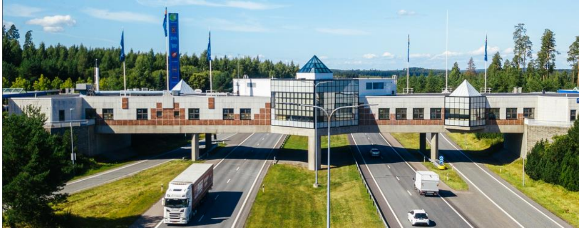
Kuva 19. Neste julkisti helmikuussa 2024 hankkeen raskaan kaluston suurteholatauspisteen avaamisesta valtatie 3:n varrella sijaitsevalla Linnatuulen alueella vuoden 2024 jälkipuoliskolla. Kuva: Neste.
