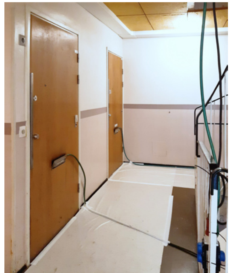
Rastitie 2:n putkiremontin toista vaihetta
