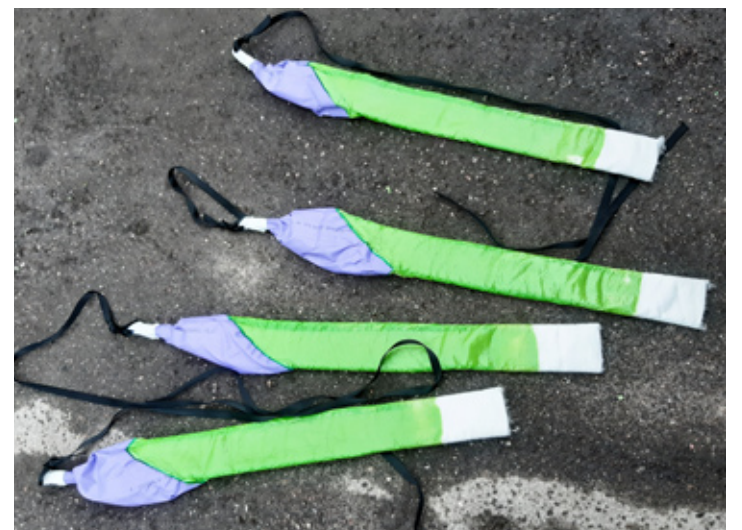
Putken sisäpintoja WC-linjaan vetolenkillä
