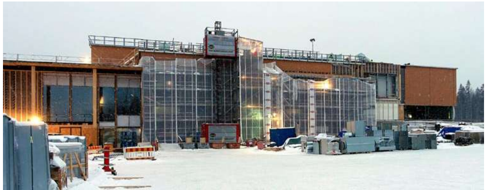
Uimahallin seinät ja katto ovat paikallaan
