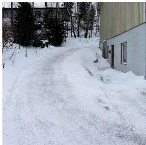
Uusi ramppi on loivempi
