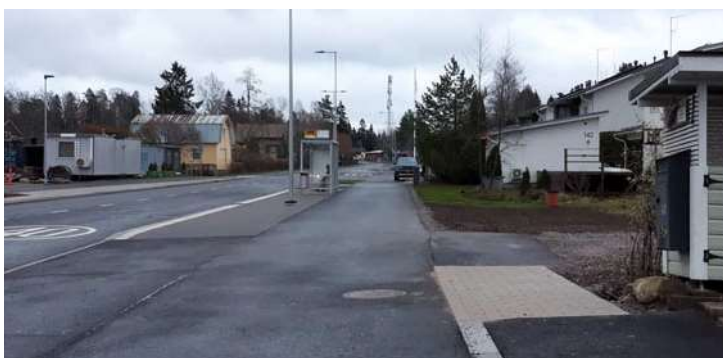
Laurintie remonitin valmistuttua
