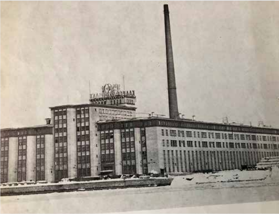
Kaapelitehtaan rakennus, jonka torniosan yläkerroksissa Salmisaaren yliopisto toimi. Kuva on vuodelta 1961. Kuva: Abacus-lehti/Suomen Kaapelitehdas
