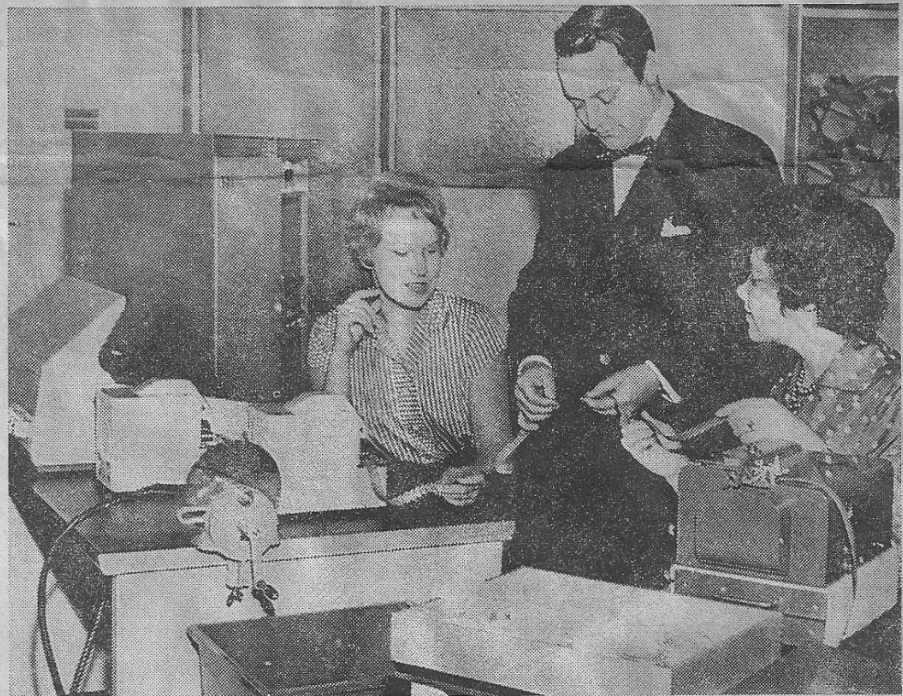
KAAPELITEHTAAN SÄHKÖAIVOT. Kuvassamme näkyvä korkea "laatikko" on varsinainen tietojen käsittelykone ja etualalla koneen ohjauspulpetti. Koneen ääressä (vas.) Seija Pellinen, Rea Holmberg ja ins. Monni.
