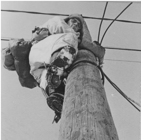
Varusmiehenä puhelinlinjaa rakentamassa 1978.
