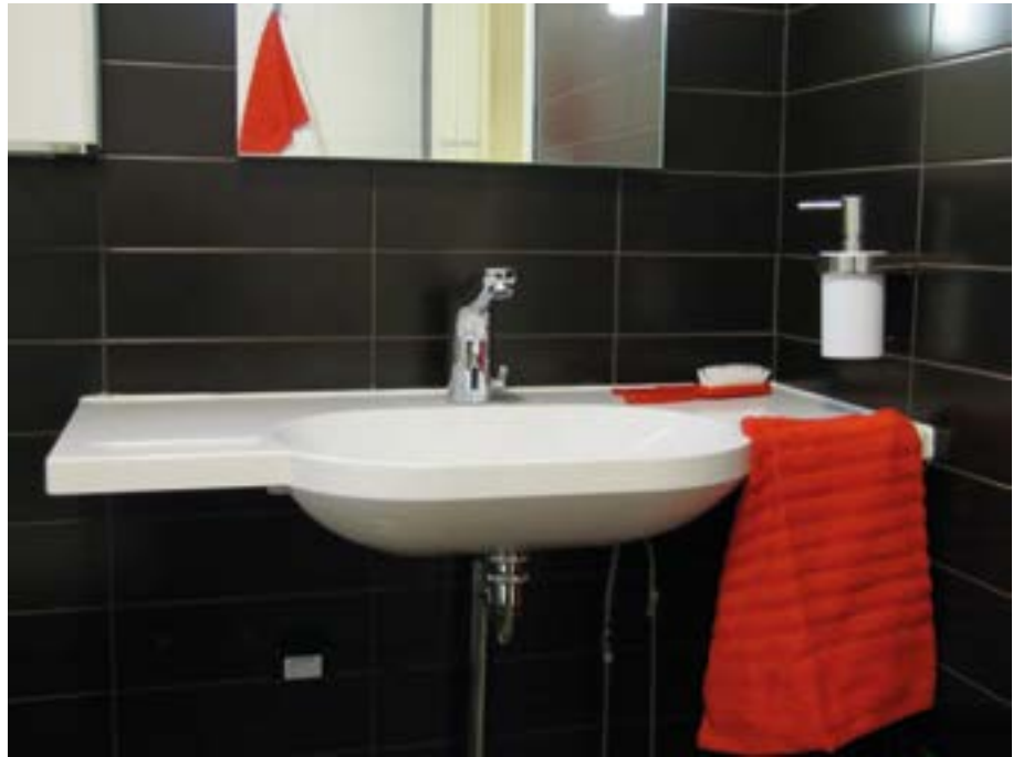
Tukikaiteella varustettu pesuallas.
