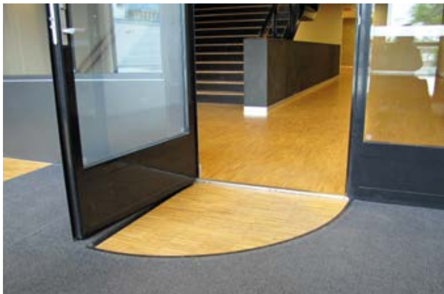
Kulkijaa kohden avautuvan oven edessä tarvittava turvaetäisyys merkitään kulkuväylän pintaan tummuus- ja materiaalikontrastina.
