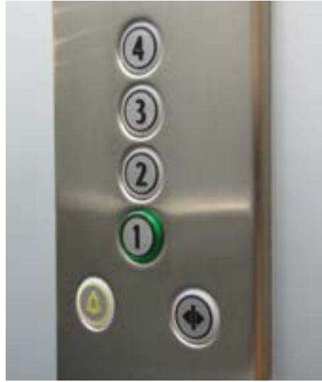
Painikkeiden kohomerkinät erottuvat selkeänä tummuuskontrastina taustasta. Uloskäyntikerroksen painike poikkeaa väriltään muista painikkeista ja on koholla.
