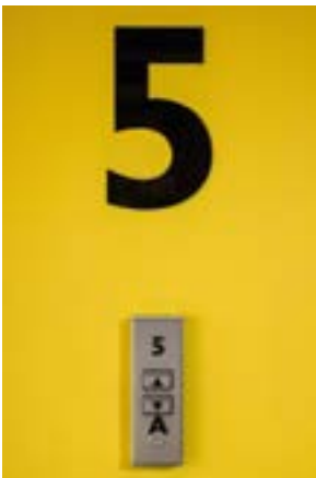
Koho-opasteena toteutettu kerrostason numeromerkintä hissien kutsupainikkeen yläpuolella.
