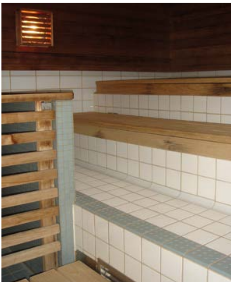
Tummuuskontrasteja voidaan hyödyntää lauteiden reunan korostamisessa.
