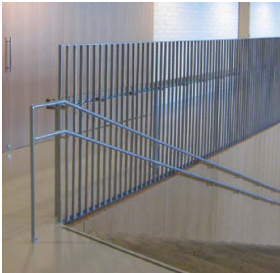
Käsijohteet asennetaan 900 mm:n ja 700 mm:n korkeuksille.
