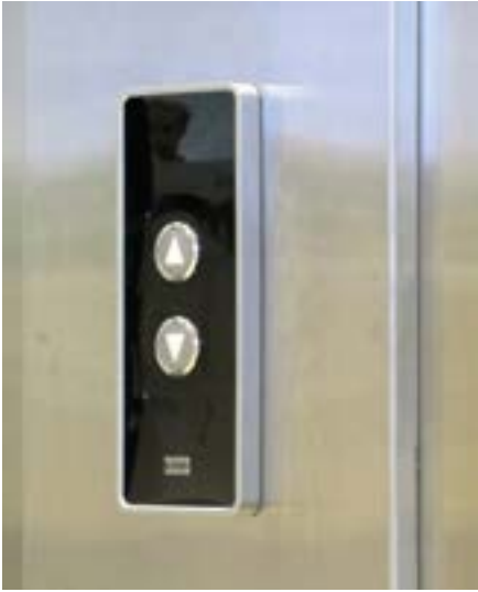
Hissin kutsupainikkeet erottuvat paneelista ja paneeli taustasta.
