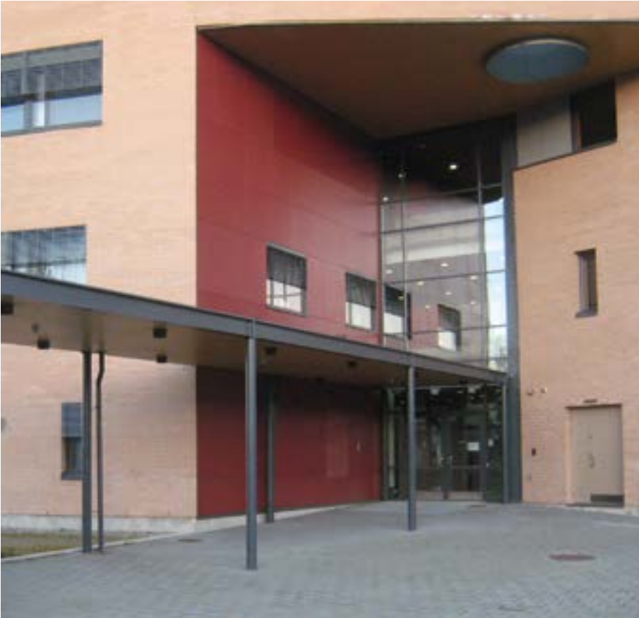
Katos helpottaa sisäänkäynnin havaitsemista.
