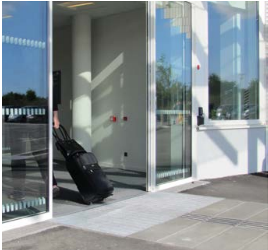
Ovenedusritilä on upotettu tasanteeseen, jolloin se ei muodosta liikumista hankaloittavaa tasoeroa.
