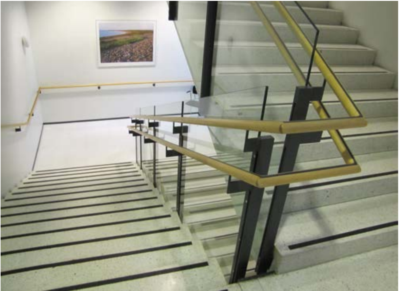
Käsijohteet jatkuvat yhtenäisinä myös välitasanteella.
