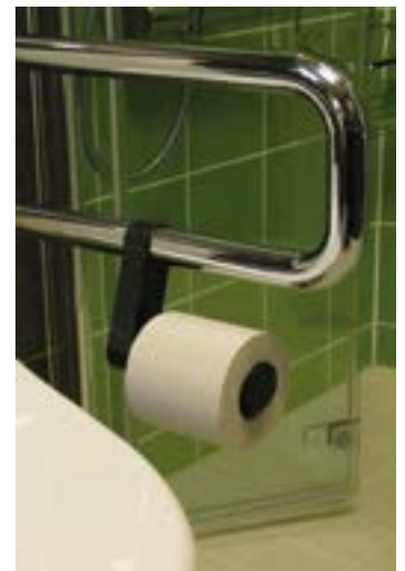
Käsitukeen kiinnitetty wc-paperiteline.
