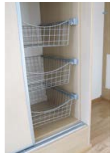
Vaatekaappien käyttökelpoisuutta lisäävät ulosvedettävät ritiläkorit.
