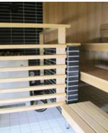
Kiuas suojataan koko korkeudeltaan suojakaiteella.
