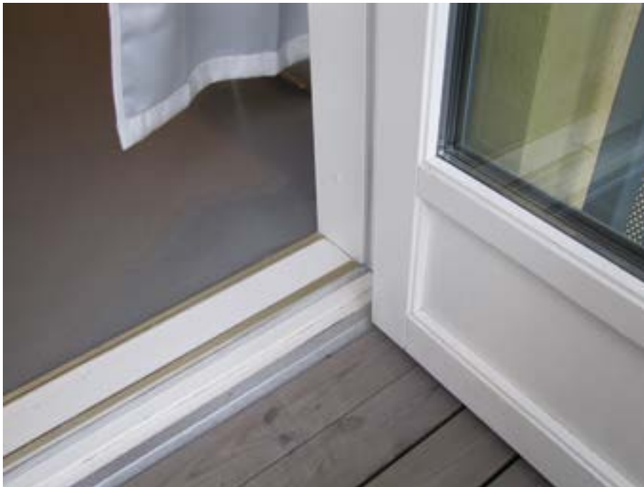
Parveketaso on sijoitettu 80...120 mm kynnyksen yläpintaa alemmaksi, jolloin kynnyksellä saadaan 20 mm korkeaksi irrotettavan ritilän avulla.
