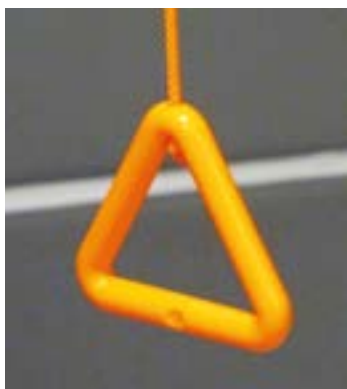
Wc-tilan hälytysjärjestelmän naru erottuu tummuuskontrastina ympäristöstä.
