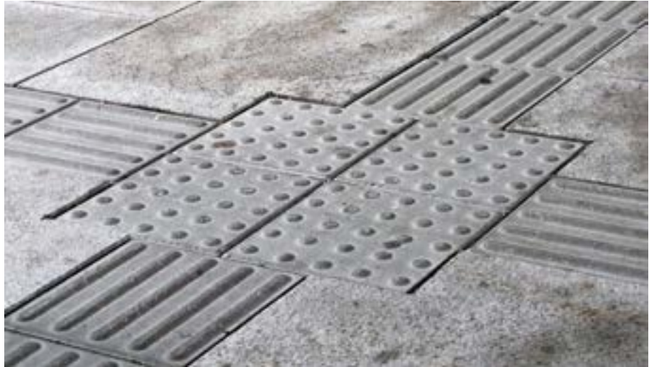
Kulkuväylän risteyskohdan opastava merkintä.
