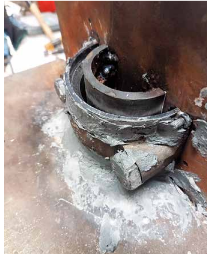
Kaikki raot tiivistetään huolellisesti pakoputkimassalla.
