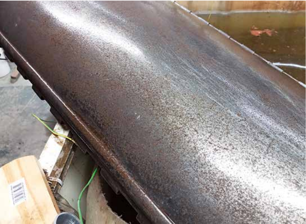
Osa on ollut muutaman tunnin happoaltaassa, suurin osa näkyvästä ruosteesta on jo irtaantunut ja se harjataan pois.
