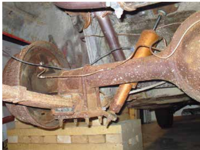
Pohja painepesun jälkeen
