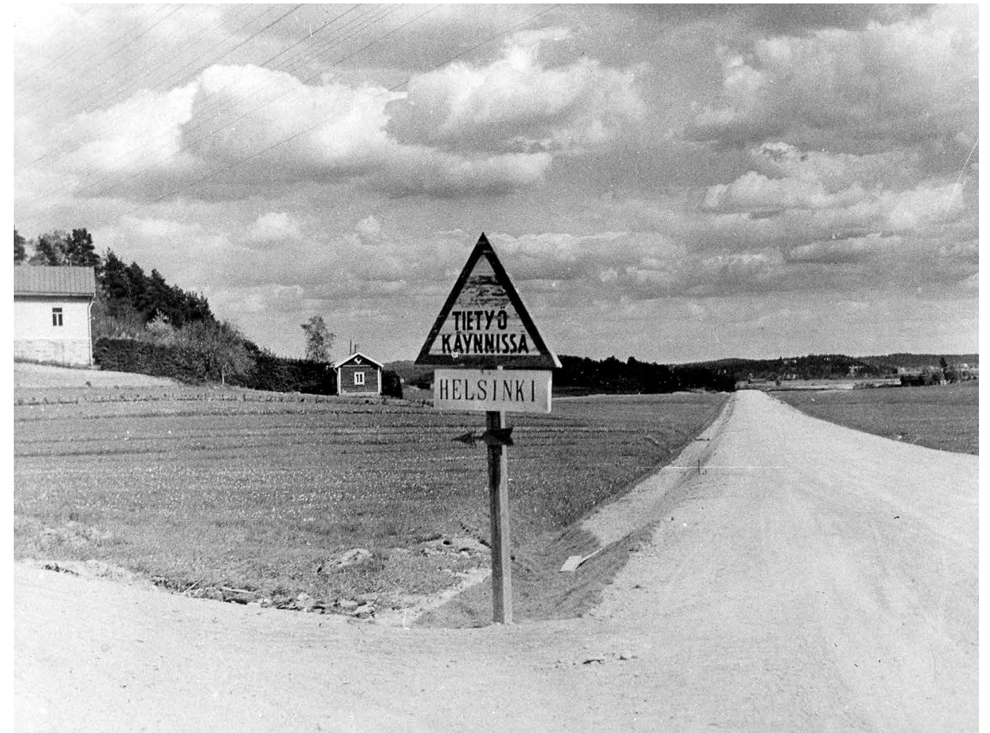
Vähilläkin merkeillä pärjättiin, kun oli luovuutta. Piikkiön suoralla Turku-Helsinki-maantien työmaalla 1930-luvun alussa oli tiettyö käynnissä ja näin yleisen varoitusmerkin lisäteksti kertookin. Kuvaus aika 1933-1934. Kuva: Väylävirasto/Mobilia
