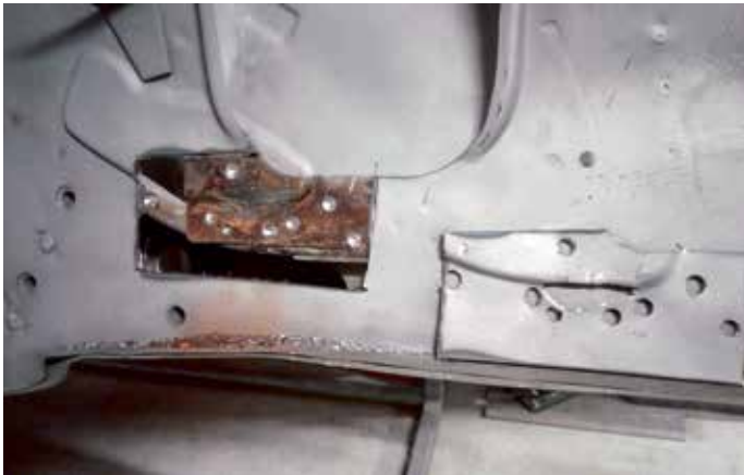
Lähtötilanne, ruostuneesta kohdasta on irrotettu pala.
