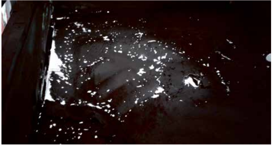
Tähtitaivaskuvio lattiapellissä hiekkapuhalluksen jälkeen.
