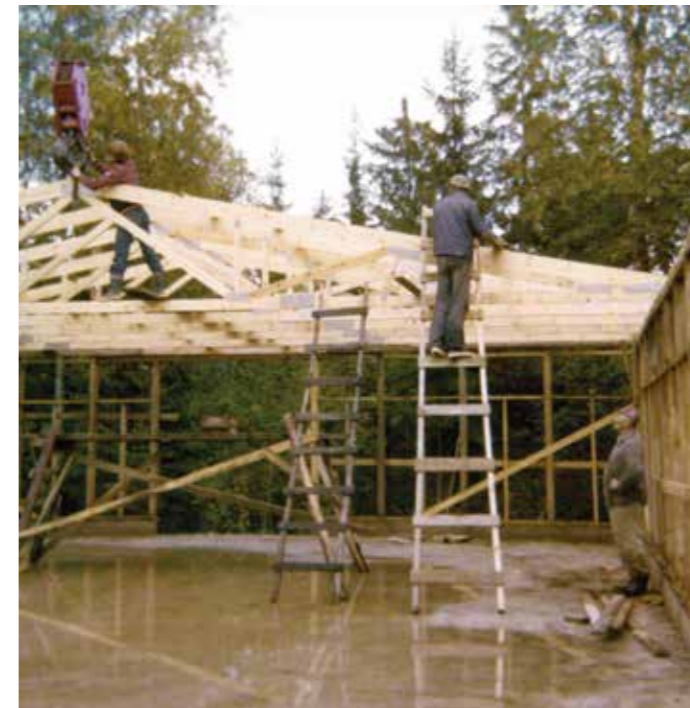
Seppo kävi aina irrottamassa koukun, kun minä sain kattotuolin kiinnitettyä.
