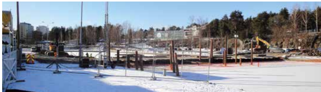
Työsilta kuvattuna 13.2.2025, aika lailla juuri valmistuneena, ainakin ensimmäisenä kauniina päivänä valmistumisensa jälkeen. Työsilta näyttää paikan, mistä silta tulee kulkemaan. Särkänniemen puolella silta on kaksihaarainen. Taustalla hämmöttää, että parkkipaikka Särkänniemen puolella on täynnä rakennustarvikkeita ja maakasoja.
