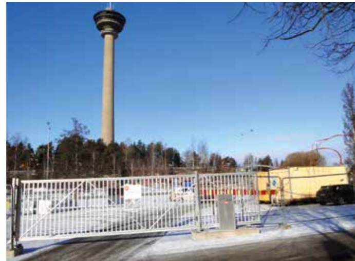
On vähän tylyn näköinen este Mustassalahdessa. Työmaa-alue sulkee yleisön parkkikentän käytöstä pois. Lapussa lukee, että työ on valmis lokakuussa 2026.
