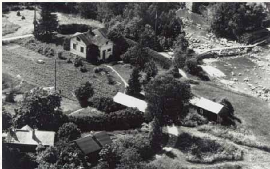
Efter att kvarnens verksamhet upphörde lade ingen ut isbommarna av stora stockar för att skydda dammen. 1956 rev isen dammen och brofundamenten. På bilden syns den tillfälliga bron som byggdes på samma plats.
