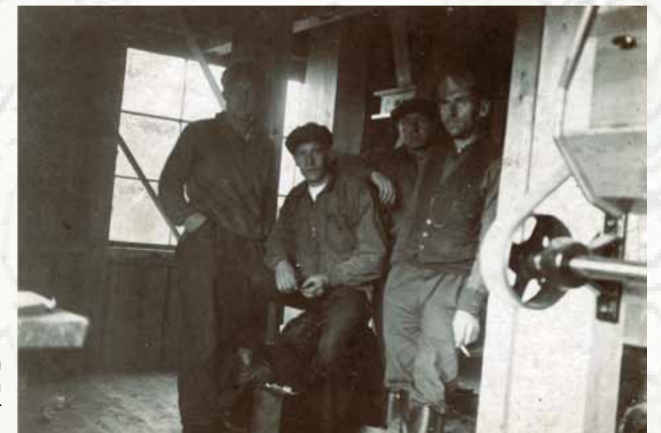
Vetesiktmaskineriet kom från Malmö och männen på bilden är montörer som installerade det.
