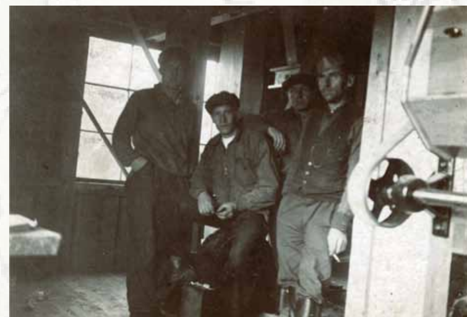
Vehnämyllyn laitteisto tuotiin Malmöstä. Kuvassa ovat laitteiston asentajat.
