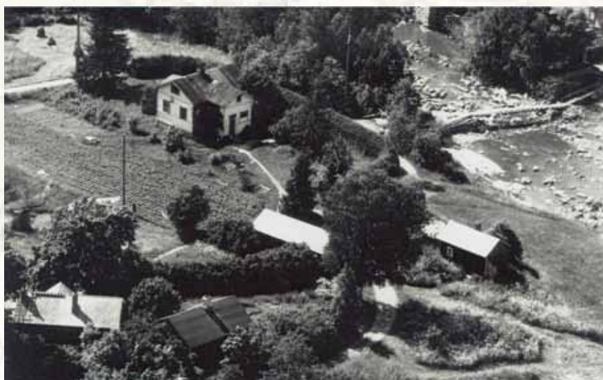
Myllytoiminnan loputtua kukaan ei virittänyt isot, tukeista olevat jääpuomit jokeen. Vuonna 1956 jää mursi padon ja siltaperustukset. Kuvassa näkyy tilapäinen silta, joka rakennettiin samalle paikalle.
