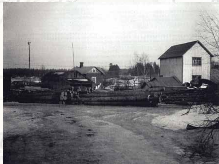
Kuvassa näkyy tukkeja, jotka odottavat saahaamista raamisahalla, joka oli vajassa myllyn yhteydessä. Myllyllä oli kaksi turbiinia, joista isompi pyöritti myllyä ja pienempi sahaa. Sahalla oli kahdeksan terää. Vuonna 1945 mylly pyöri kellon ympäri. Sodan takia myllytoiminnalle oli rajoituksia ja monet myllyt oli suljettu ja sinetöity. Myllyyn piti tulla aina Puotinkylältä, Westerkullasta, Sotungista, Östersundomista ja Håkansbölestä asti. Parhaimmillaan 32 hevosta jonotti myllyllä. 1934 Carl Carlsson otti myllytoiminnan haltuunsa Ernst Söderlingin siirrettyä toimintansa Tikkurilaan. Kuvassa 1940-luvulta näkyy vehnälajittelijan lisärakennus.
