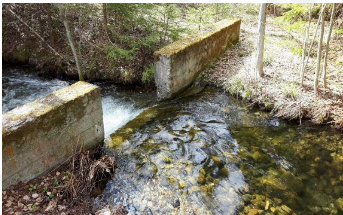
Kuva 2: Kuoringanpuron betoninen pohjapato Kuoringan luusuassa. Kuva: Mira Lukkarila, 23.5.2017.
