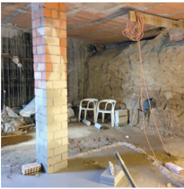
Keittiön laajennustyö etenee
