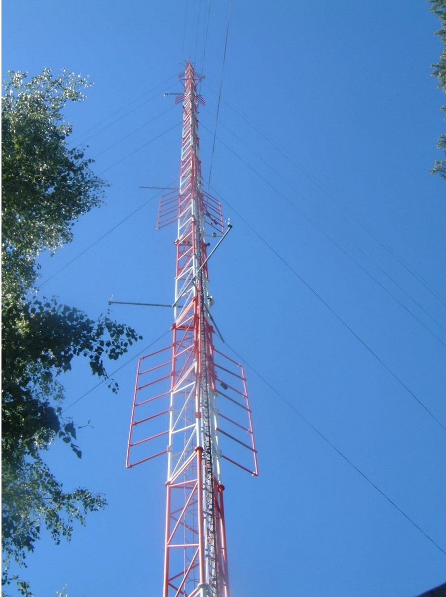
Kuva 10: Loviisan säämasto (Kuva: Ilmatieteen laitos).
