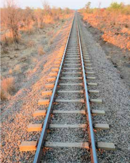
Vaihdettuja vaurioituneita betoniratapölkkyjä oli matkan varrella runsaasti
