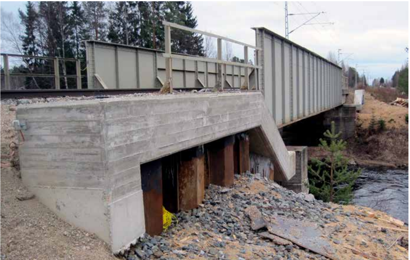
Kuva 3. Sillan taustoille rakennettiin ponttiseinät tulopenkereen painumien vähentämiseksi.
