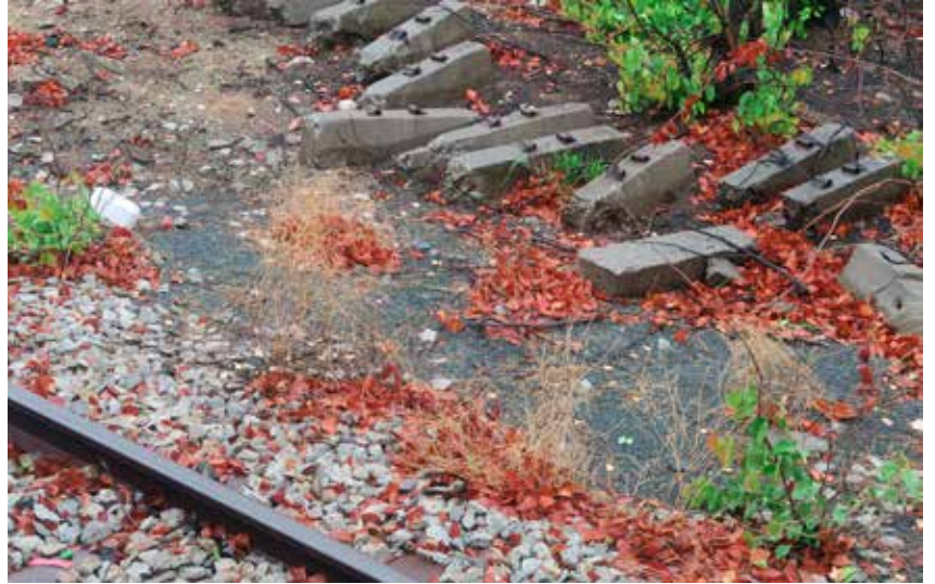
Vaihdettuja vaurioituneita betoniratapölkkyjä oli matkan varrella runsaasti
