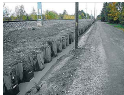
Kuva 3. Teräsponttiseinää Mellilässä (kuva Erkki Poikolainen).
