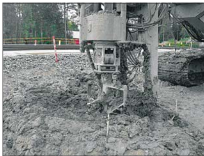
Kuva 1. Kalkkimenttistabilointia Koriällä.
