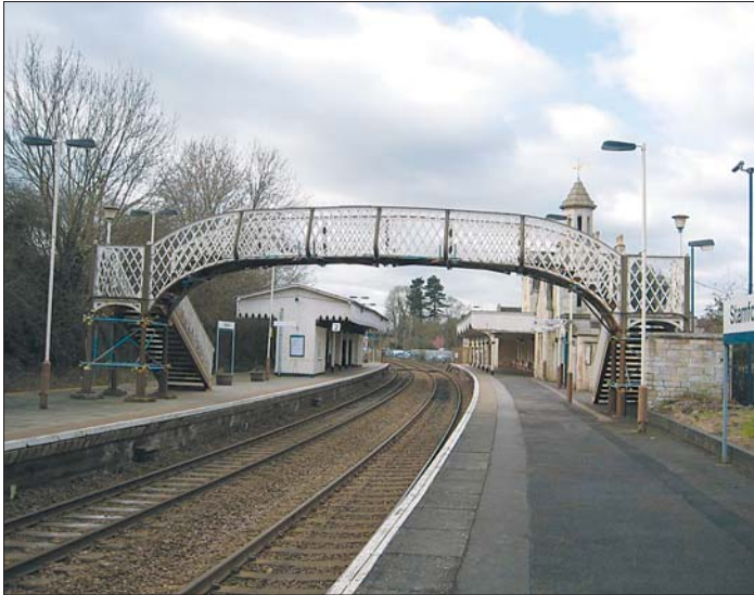
Britanniassa merkittävätkin radat voivat olla sähköistämättömiä. Kuva on Stamfordin 18000 asukkaan kaupungin asemalta Keski-Englannista (Midland).
