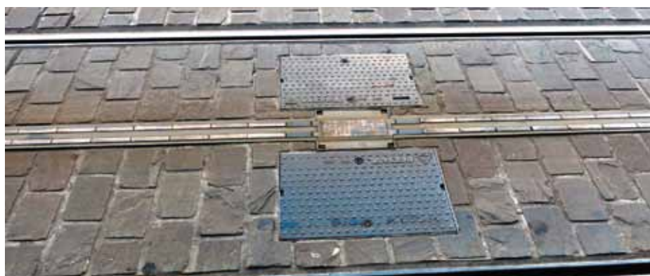
Yläkuvassa erotusjakso ja kytkentäyksikkö. Alakuvassa Bordeaux-periaate.
