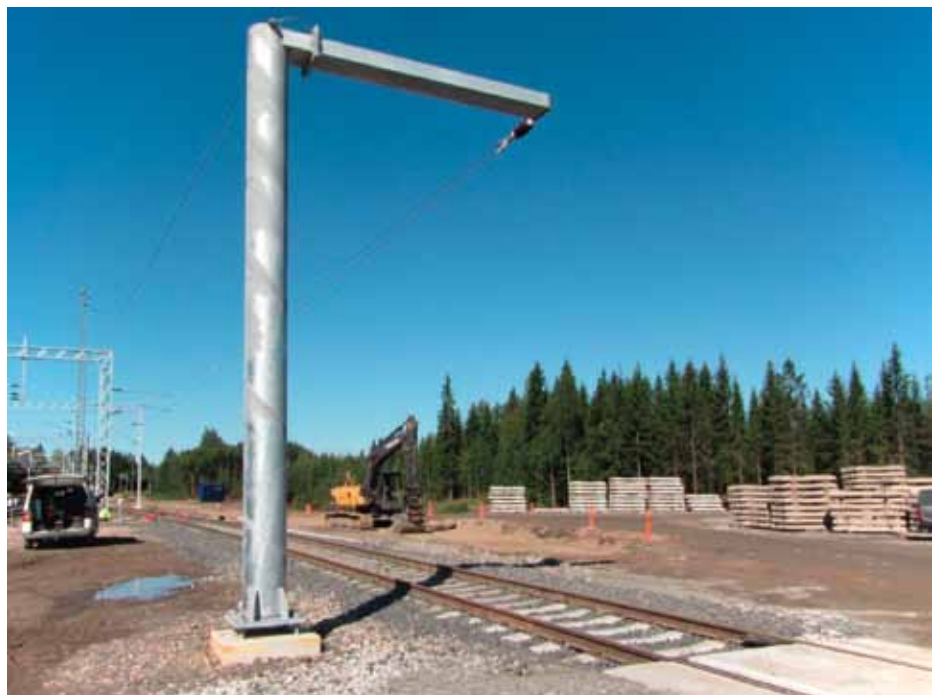
Kuva 2: Sähköistyksen päättävä pylväs kuormausraiteella
