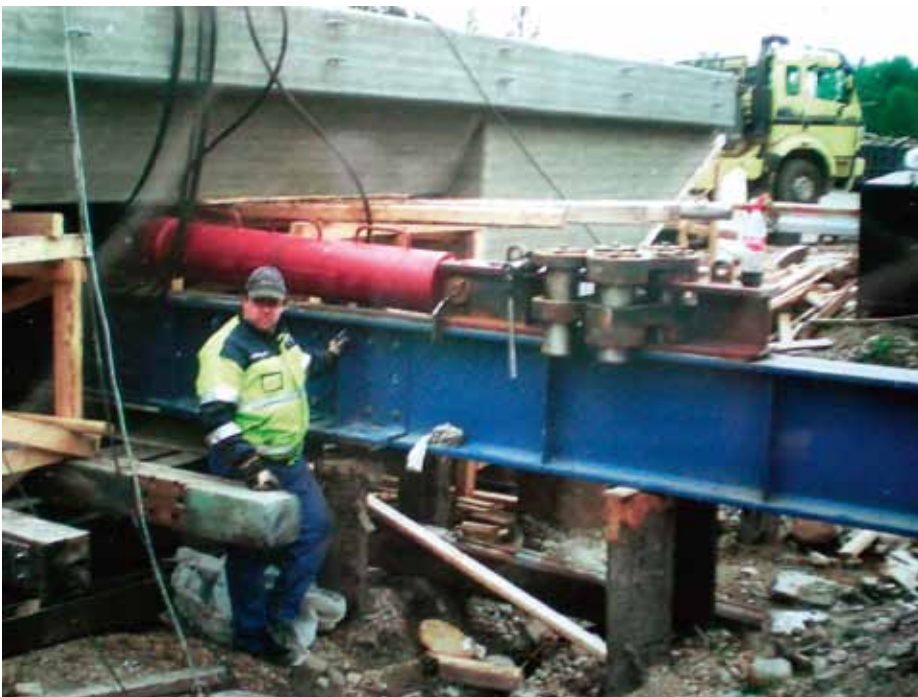
Kuva 3 Sillan siirto on käynnissä, siirtotunkin iskupituus on 1,5 metriä, siirtonopeus on n. 10 m/h
