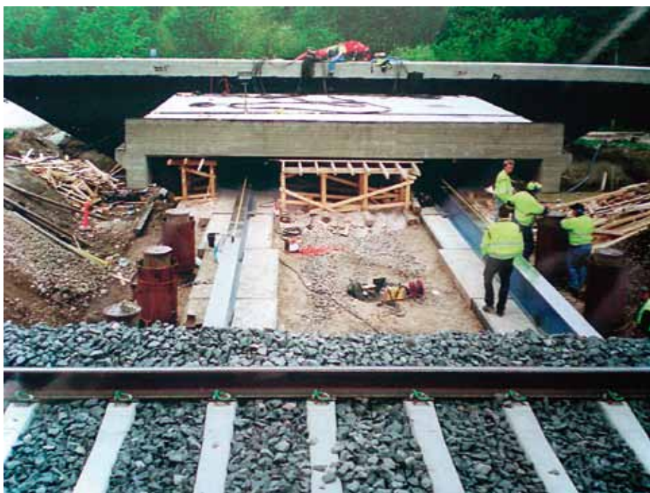
Kuva 1 Raiteen sivussa rakennettu kansilohko valmiina siirrettäväksi aiemmin siirretyn kansilohkon viereen
