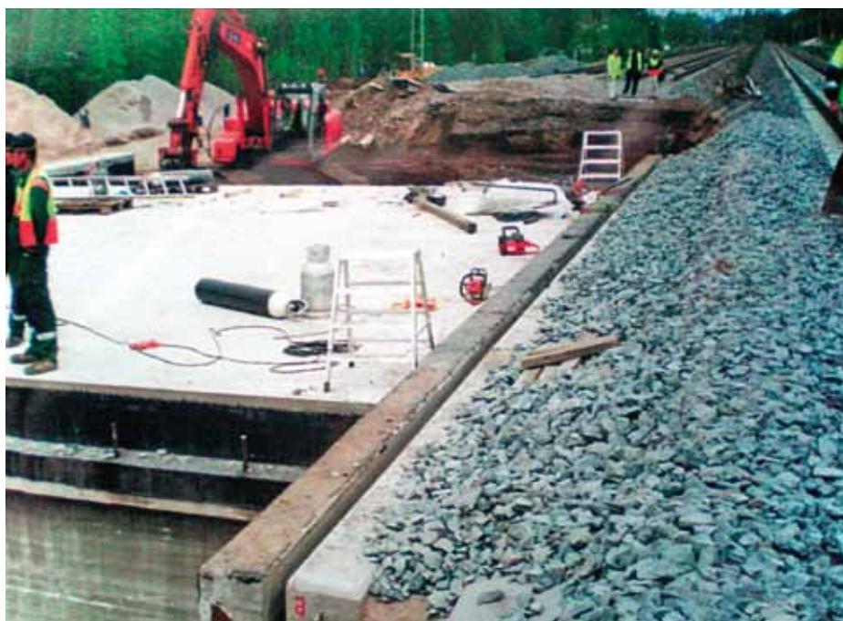
Kuva 4 Kansilohko on siirretty aiemmin siirretyn kansilohkon viereen, rakoon asennetaan vesitiivis suoja
