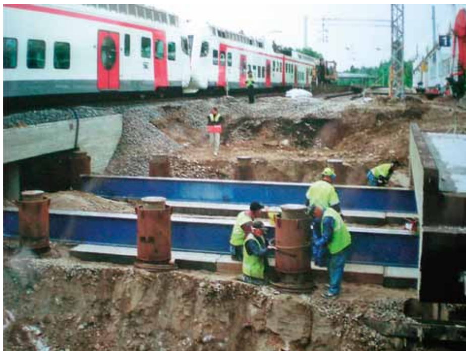
Kuva 2 Siltapilareiden päiden valmistelua siirrettävän kansilohkon tukirakenteiksi
