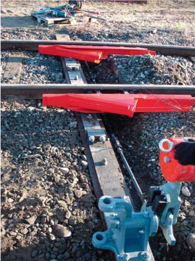
Kuva 2. Käsikäyttöinen pysäytyslaite käännettynä pois kiskoilta. Kuva Jari Viitanen
