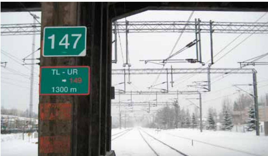
Paikantamismerkki 147 laskevaan suuntaan Toijalan liikennepaikalla. Paikantamismerkistä 147 seuraava paikantamismerkki on 146. Lisäkilvellä ilmoitetaan, että Toijalasta Urjalan suuntaan seuraava paikantamismerkki on kuitenkin 149, joka on 1300 metrin etäisyydellä tästä paikantamismerkistä 147.
