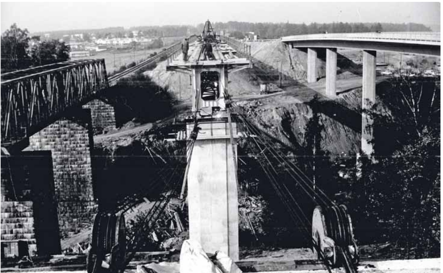
Saimaan kanavan sillan rakentaminen. Kuva VR Track Oy, siltaryhmän valokuva-arkisto
