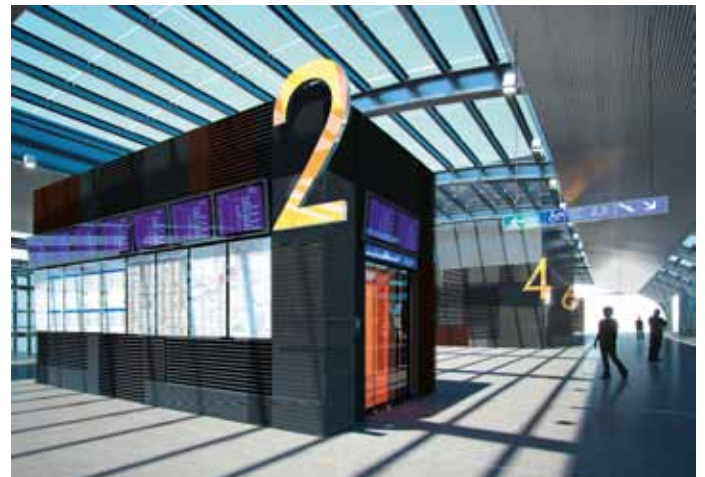
Kuva 4. Sisätiloissa hissinousujen seinät ovat akustisesti verhoil- tuja. Suuret laiturinumerot parantavat orientoitavuutta.
