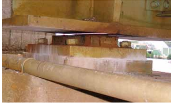
Kuva 3. Läppäsilta jää välillä ”ilmaan” alustaltaan.
