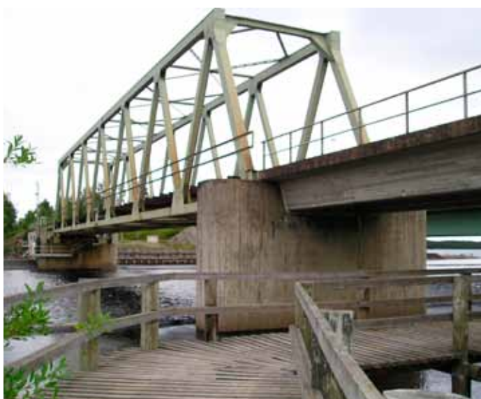
Kuva 2. Eteläiseen silta-aukkoon on rakennettu myöhemmin silta moottorikelkkareittiä varten.
