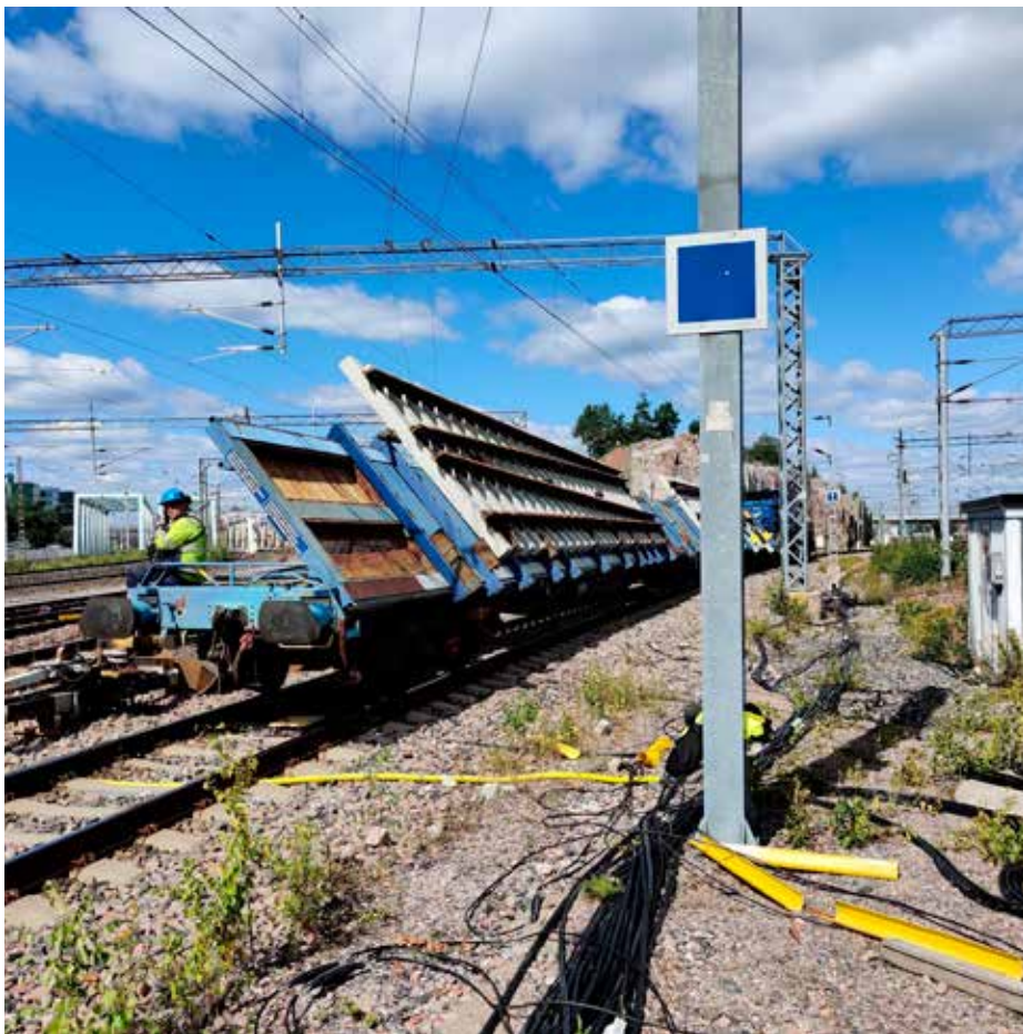
Kuva 4. Vaihdekuljetus saapuu työmaalle
