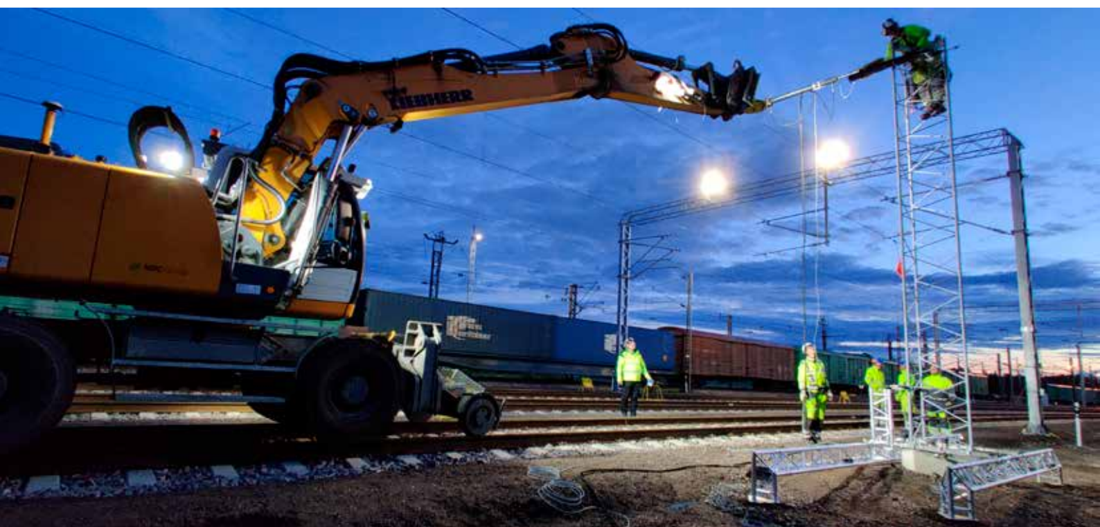
Kuva 4. Valaisinmaston perustuksen koe- kuormitus Vainikkalan ratapihalla. Kuva Valtteri Pohja.
