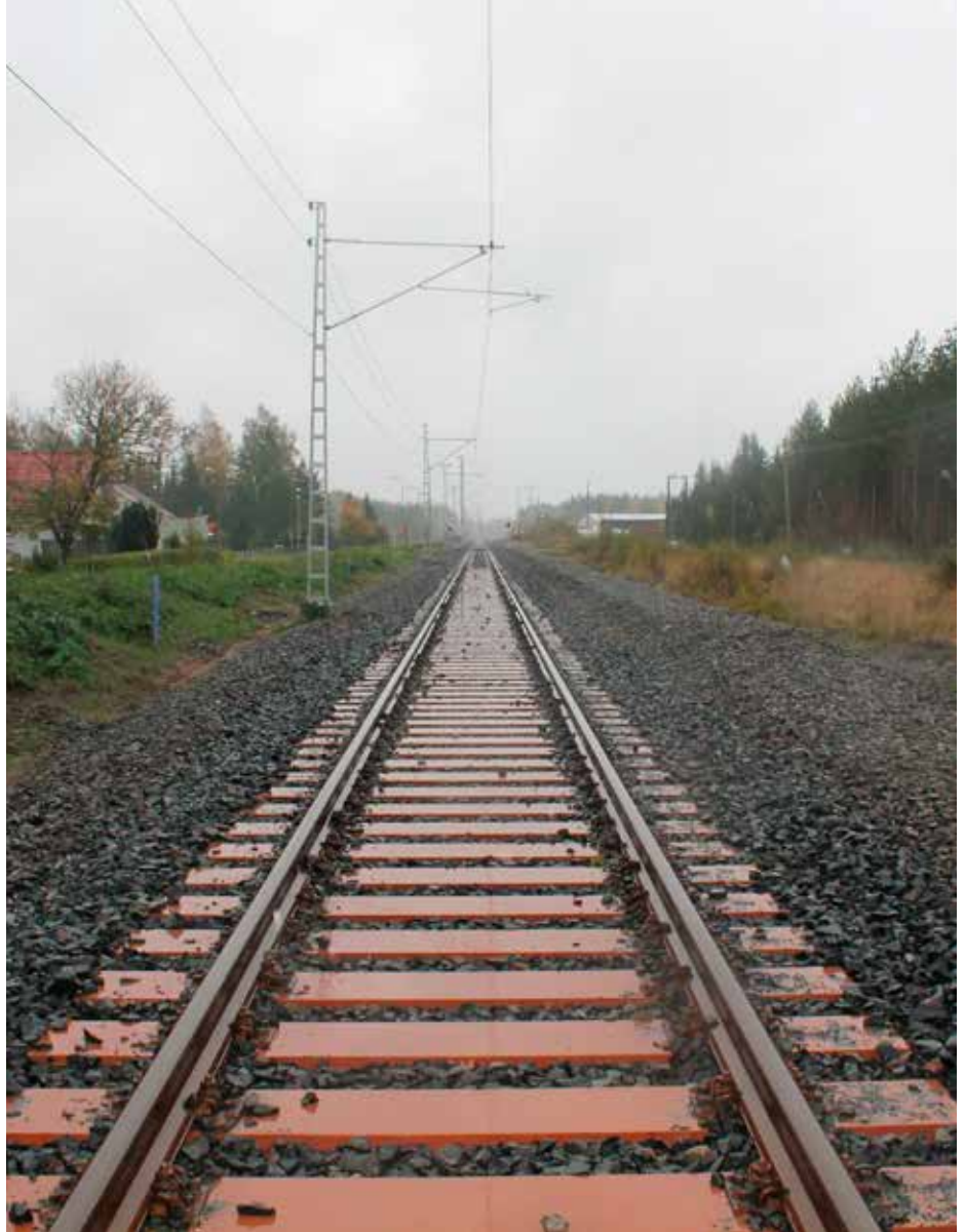
Kuva 2. Komposiittipölkkyistä rakennettu koeosuus Pori-Mäntyluoto-rataosalla. Kuva Antti Pelho.
