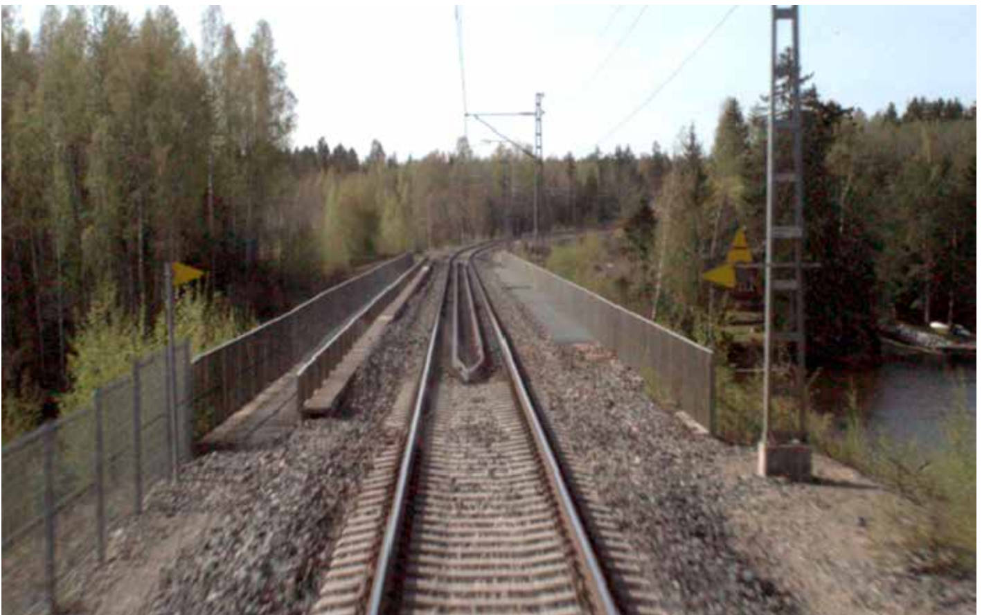
Kuva 4. Sillassa on nykyisin huoltokäytävät, mutta ei virallista jalankulkureittiä. (Kuva: Sweco Infra & Rail Oy:n arkisto)
