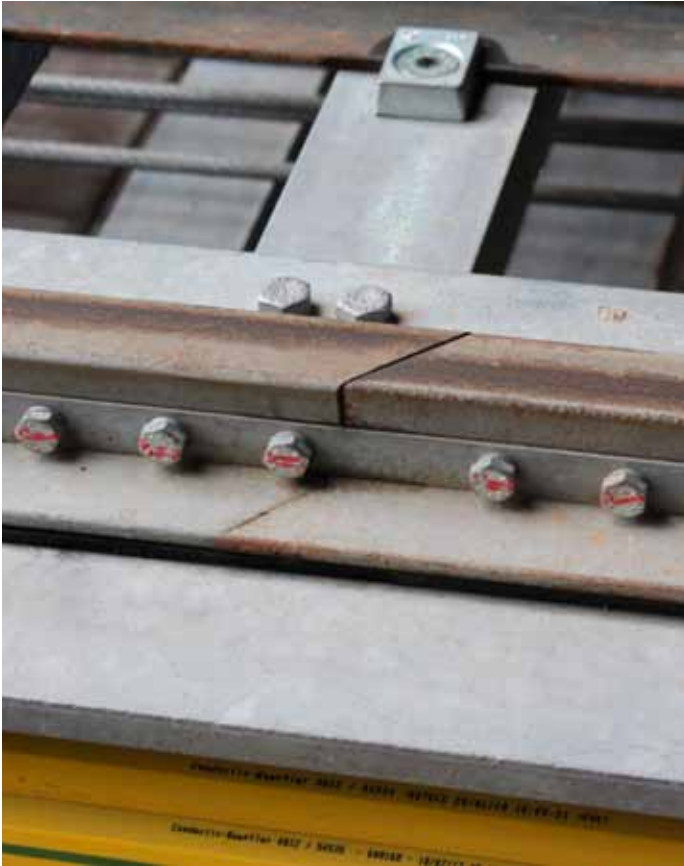
Funikulaarin radan vino kiskonjatkos, joka takaa tasaisen kulun jatkoksen yli. Valtion rataverkolla vastaavia vinoja jatkoksia on käytetty jonkin verran eristysjatkoksissa.
