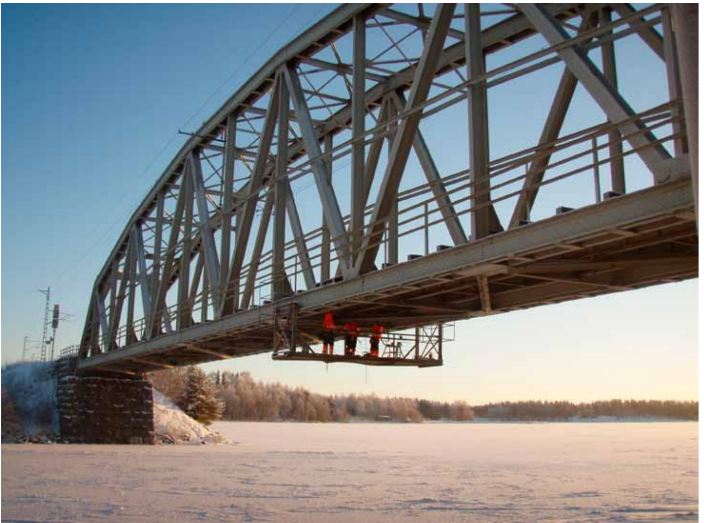
Kuva 5. Sillan korjaukset tehtiin talvella siltakorista käsin.
