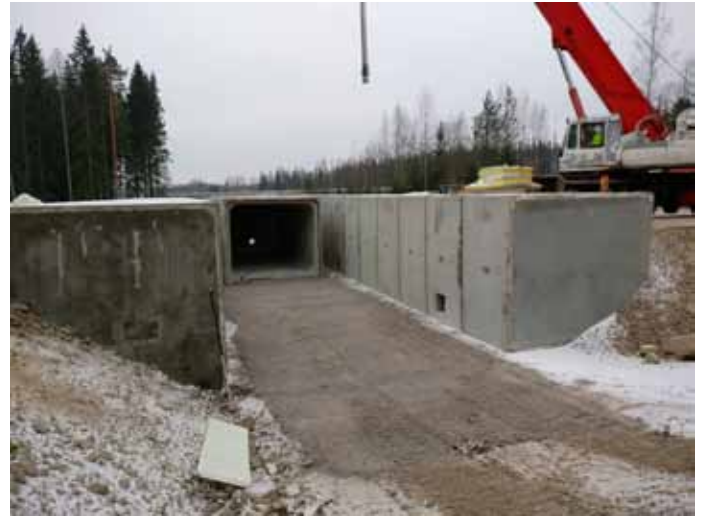
Säiliöelementtien asennus käynnissä 8.11.2018 ja 3.12.2018.
