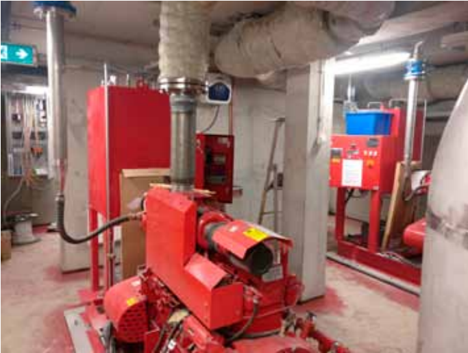
Dieselläkäyttöiset sammutusvesipumput 4.3.2019.
