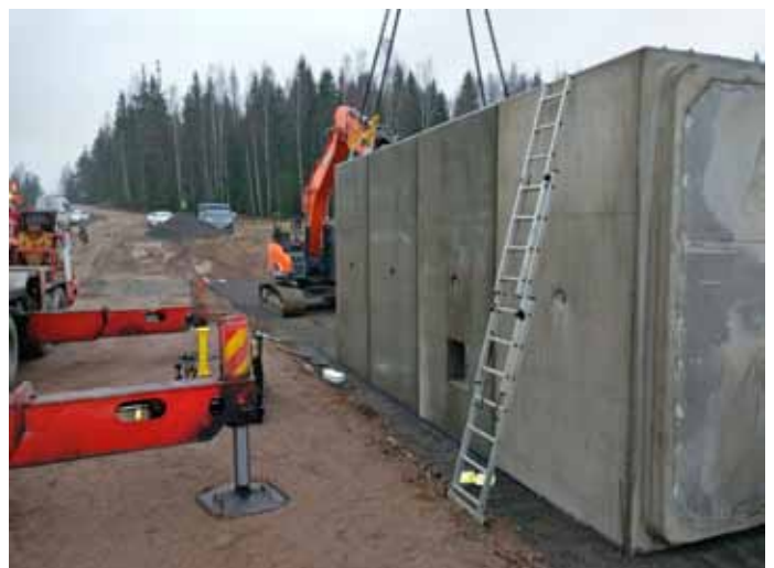
Säiliöelementtien asennus käynnissä 7.11.2018.
