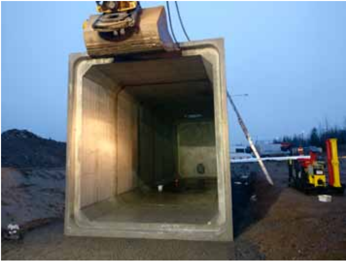
Säiliöelementtien asennus käynnissä 8.11.2018 ja 3.12.2018.
