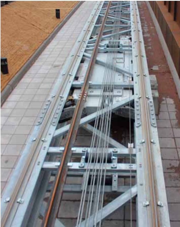
Vastapainovaunu painoltaan 3,5 tonnia kulkee henkilöradan alla.
