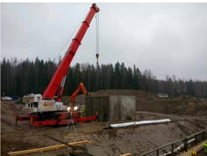
Säiliöelementtien asennus käynnissä 7.11.2018.
