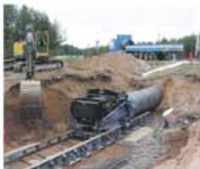
Työntöporasta American Augers 72-1200NG koneella, DN1600 asennus.
