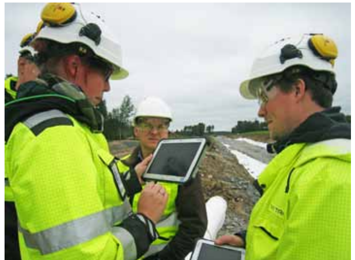
Kuva 2 Työmaanohjausta tietomallien avulla Kokkola-Riippa RU1 -työmaalla. (Kuva Ari Falck, VR Track Oy)
