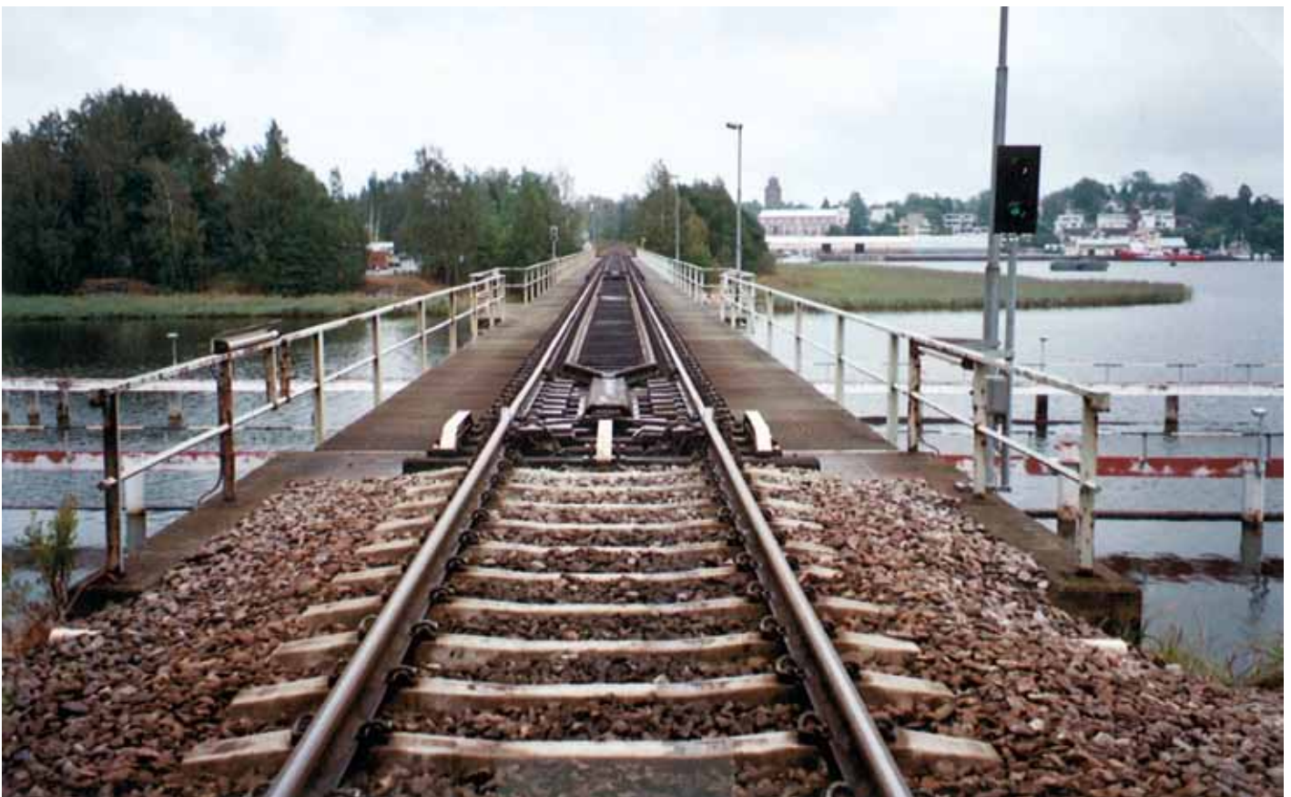
Kuva 6. Kääntösillan ratatekniikka läntisessä salmessa.
