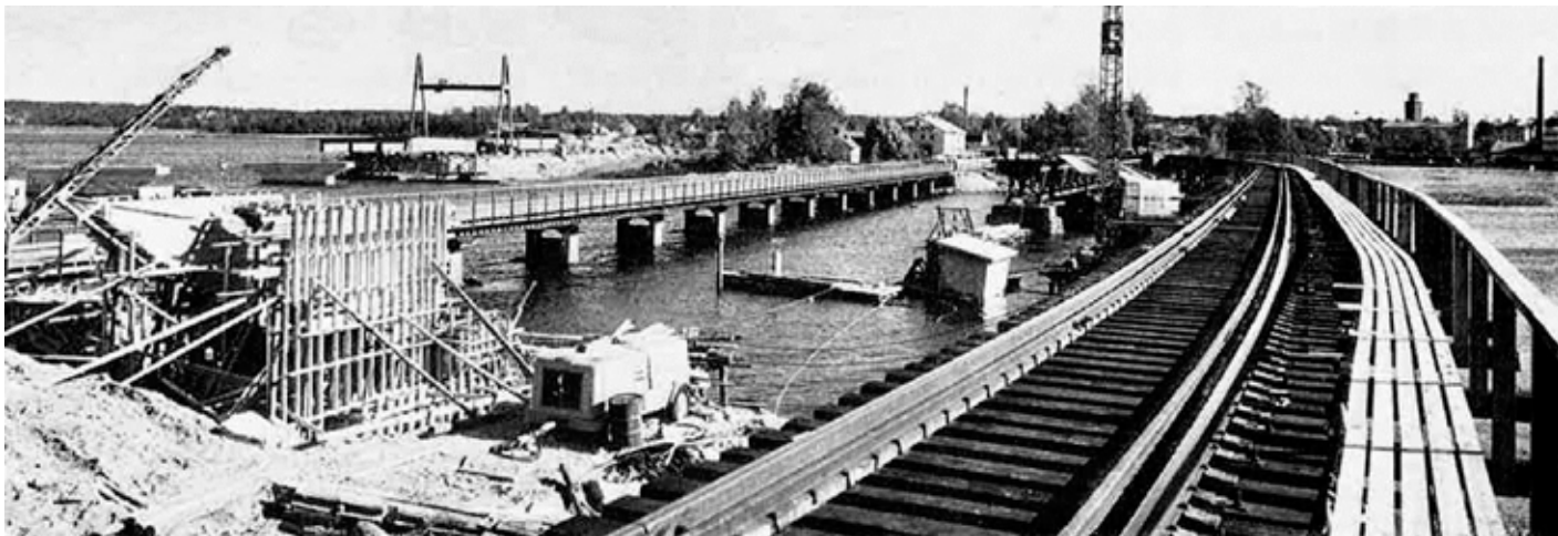
Kuva 4. Oikealla läntisen salmen väistöraiteen pukkisilta, tästä pohjoiseen uuden sillan alusrakennetöiden työmaa, takana vanha tiesilta ja kauempana aloitettu uuden maantiesillan rakentaminen (Kuva Tielehti 1970).
