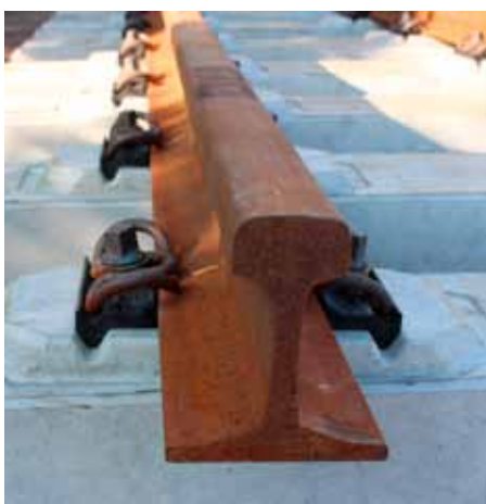
Kiskonkallistus 1:40 on toteutettu suoraan vaihdepölkkyihin tehdyillä kallistuksilla. Kiinnitysten rakenne on nyt sama kuin normaaleissa linjapölkkyissä.
