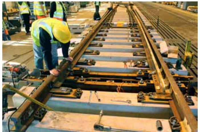
Kaukalopölkyn varustelu käynnissä Pieksämäellä. Tässä vaihteessa on takana perinteinen Railex-kääntöavustin.
