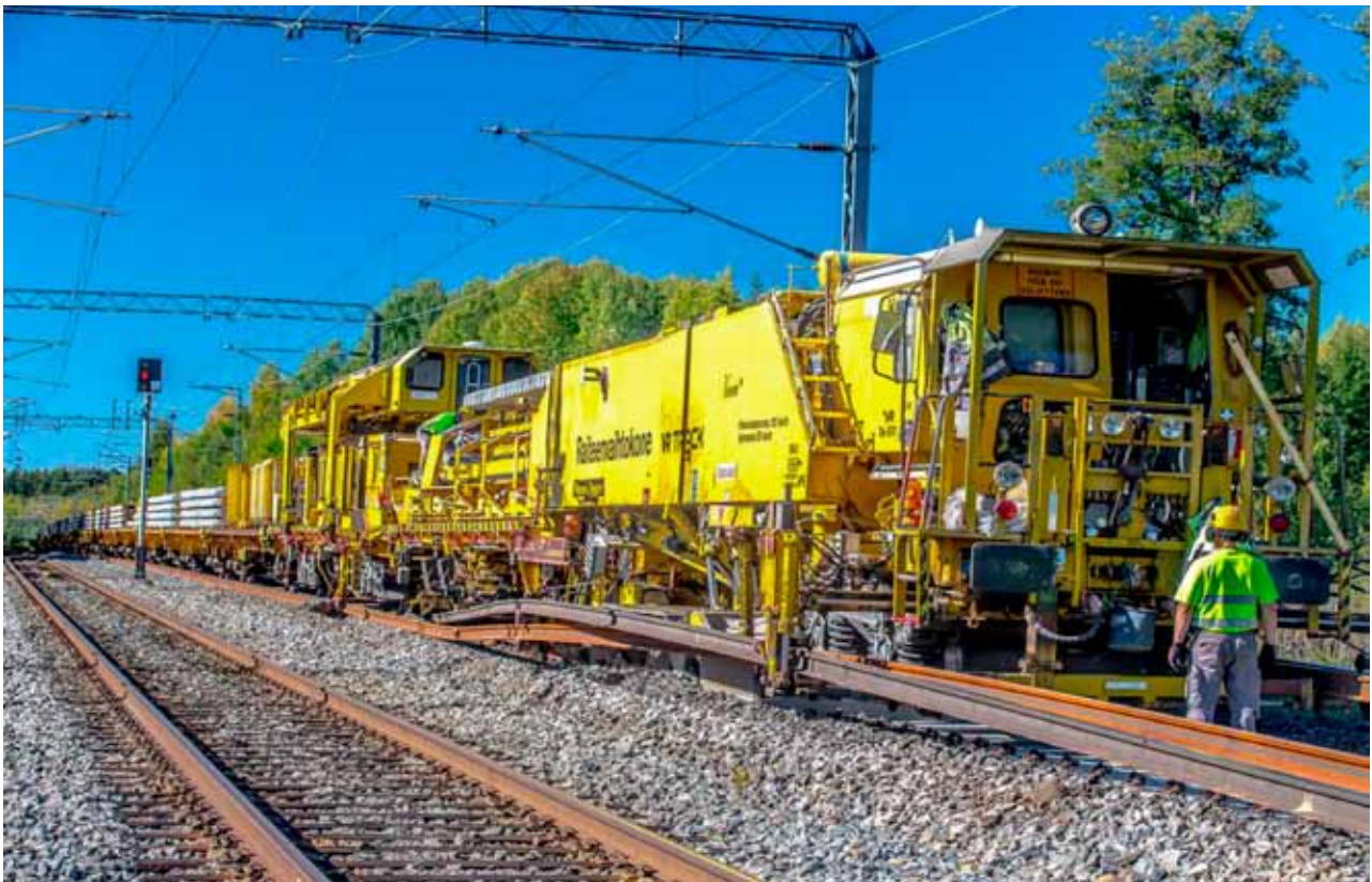
Raiteenvaihtokone Veeran työskentelyä kesällä 2013. Kuva Reijo Keskikiikoinen
