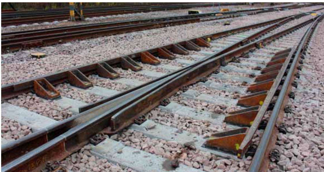
Risteys- ja vastakiskosovitukset asennettuina.
