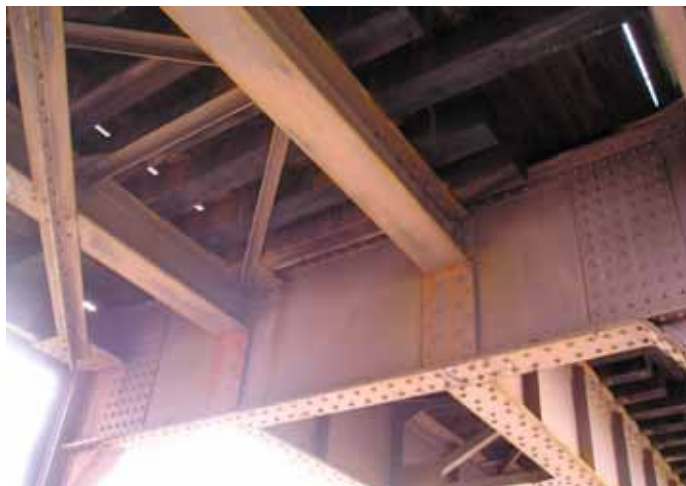
Sillan ratarakenteita kannattavat niitatut teräsosat
