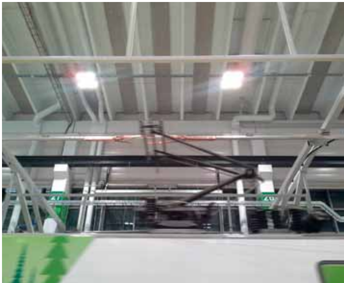
Ryhmyseristin kiintoajojohtimessa, Kuva: Mikko Korpela
