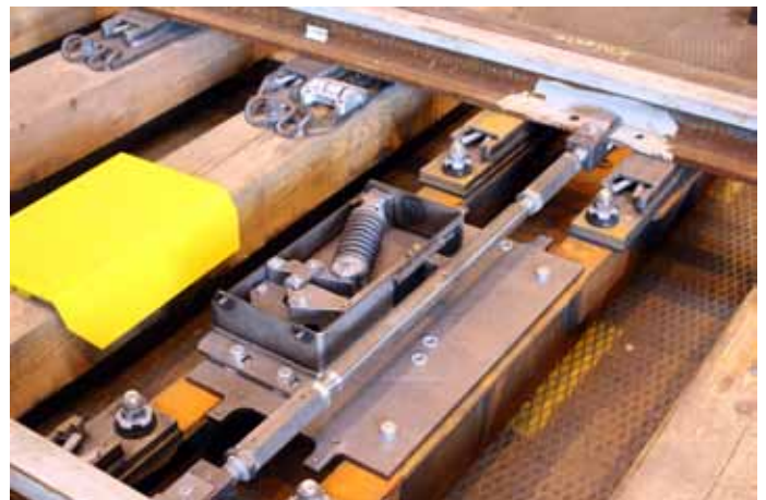
Uusi "Spring Device"-kääntöavustin suojakansi irrotettuna, tässä vielä väliaikaisena koeasennuksena puupölkkyillä.
