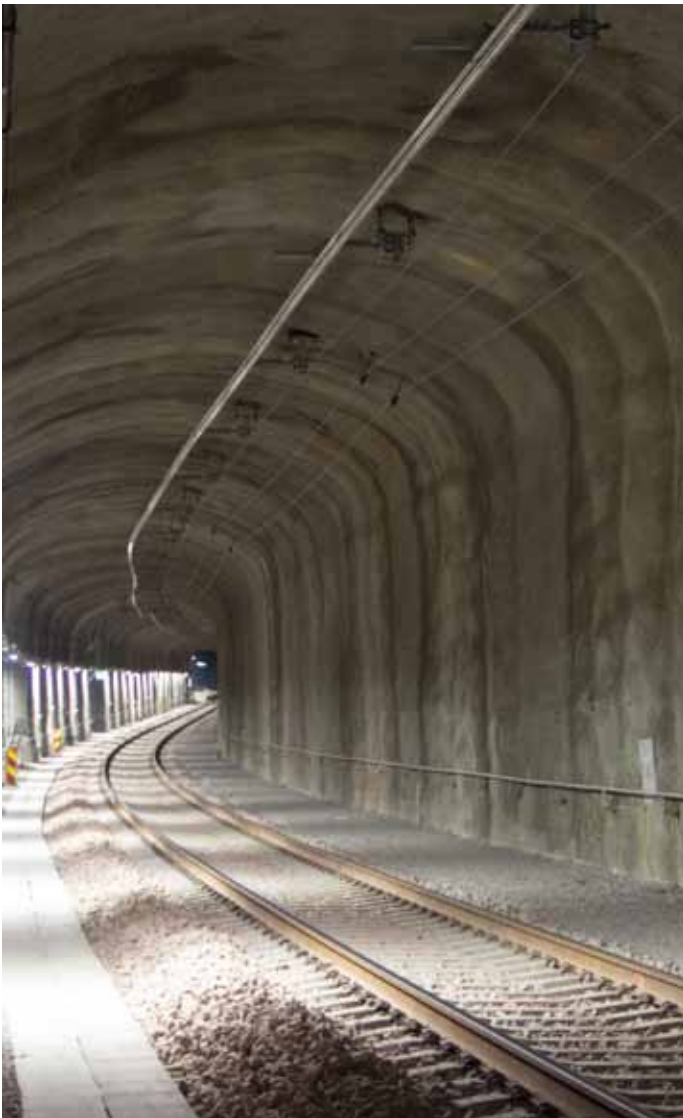
Valmista kiintoajojohtinasennusta Kehäradalla. Kuva: Esa Ojanperä
