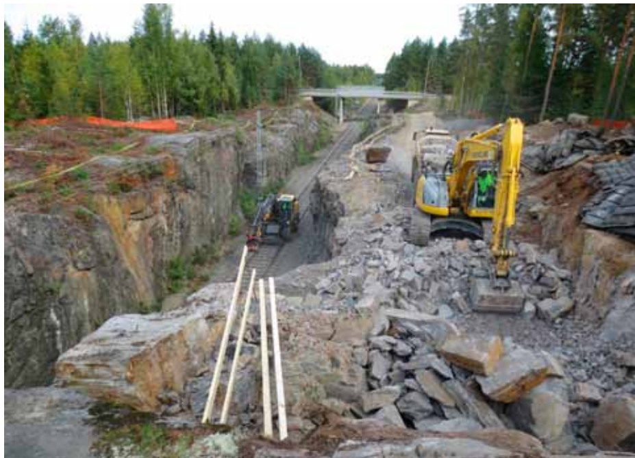
Risteen kallioleikkaustyöt käynnissä syksyllä 2013. Kuva Mikko Nyhä
