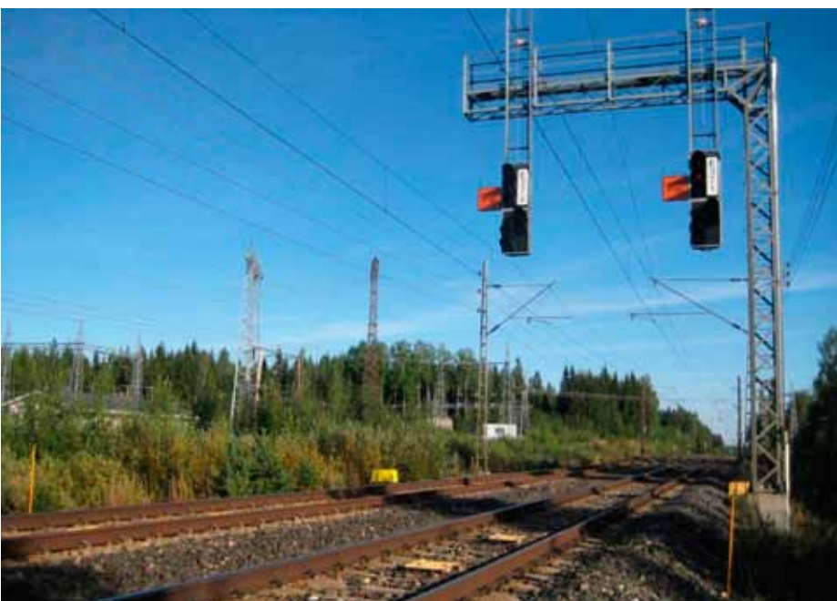
Pää- ja esiopastimet opastinulokkeessa Palopuron liikennepaikan rajalla
