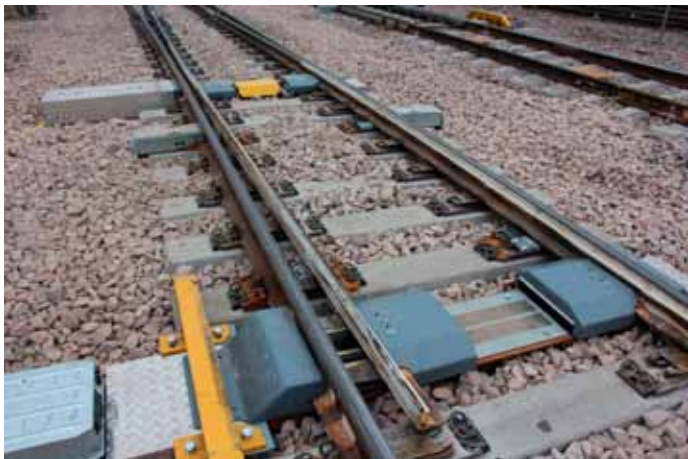
Kielisovitukset valmiina radassa. Tässä vaihteessa on uusi kääntöavustin.
