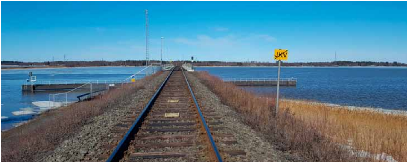
Kuva 2. Tulo sillalle meripenkereeltä Tahkoluodon suuntaan.
