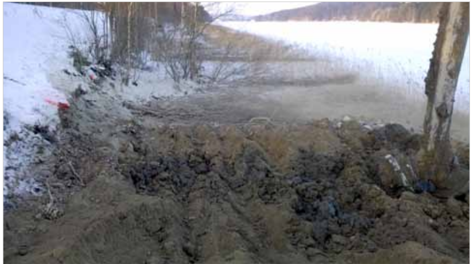
Kuva 3. Massastabilointia ratapenkereen vieressä.
