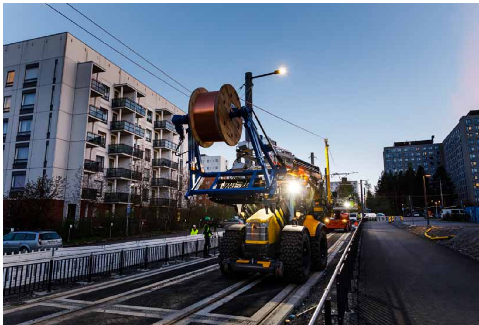
Valmista ratajohtoa Insinöörinkadulla. Kuvassa näkyy myös kääntöorsia ja valaistuksen yhteiskäyttöpylväitä.
