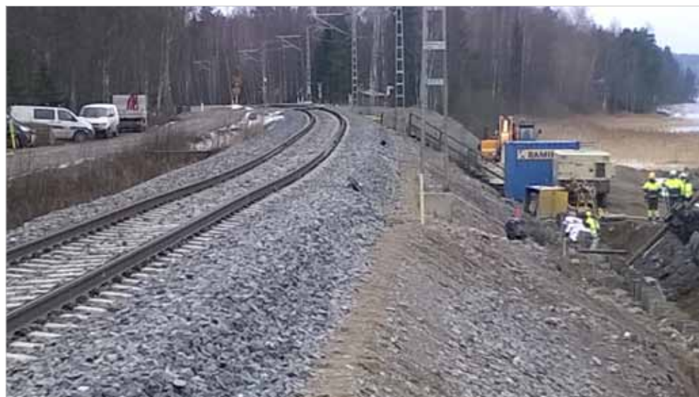
Kuva 6. Ratapenger ennen ponttiseinän asennuksen alkamista.
