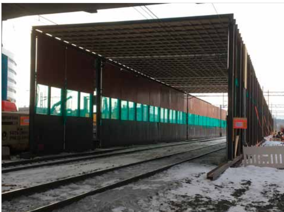
Rakentamisen aikainen suojarakenne pääraiteiden kohdalla / Aarno Kinnunen.
