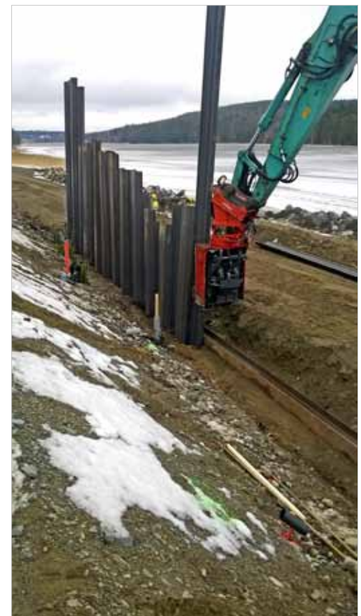
Kuva 7. Ponttiseinien asennusta
