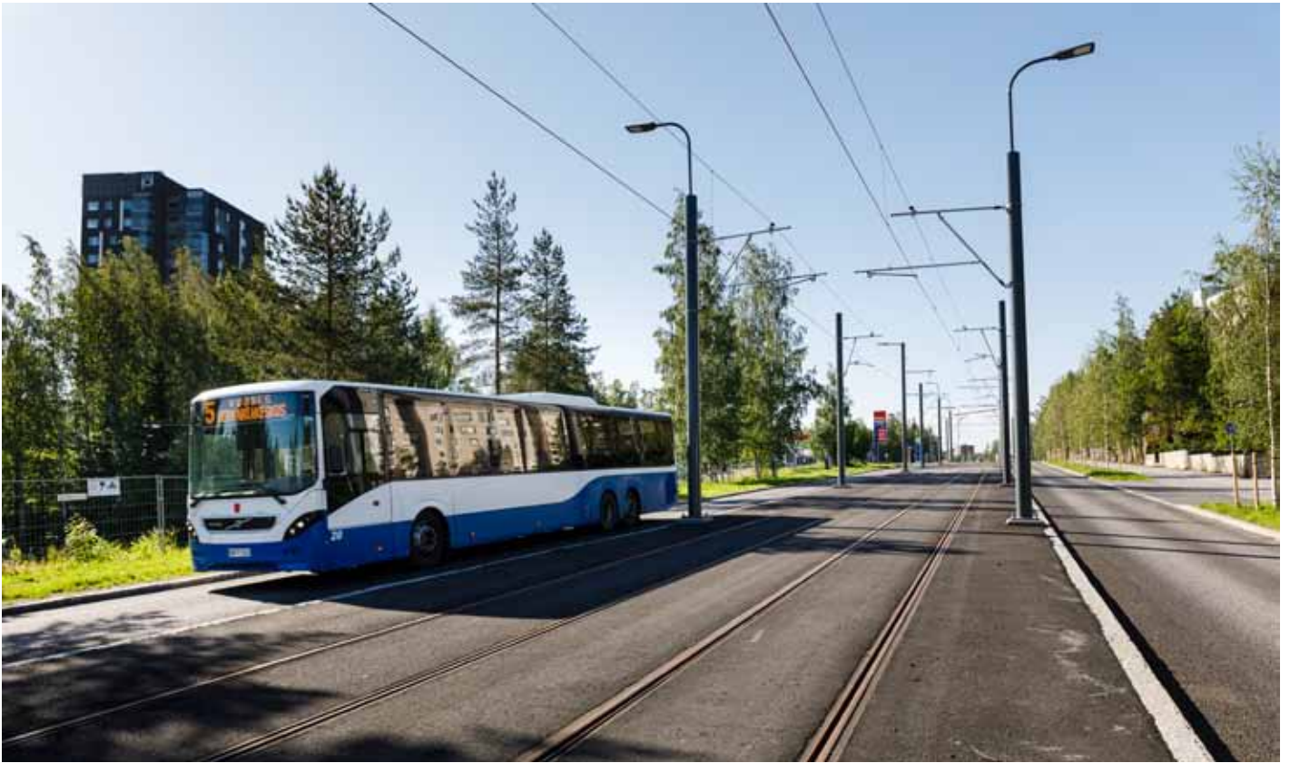
Valmista ratajohtoa Insinöörinkadulla. Kuvassa näkyy myös kääntöorsia ja valaistuksen yhteiskäyttöpylväitä.
