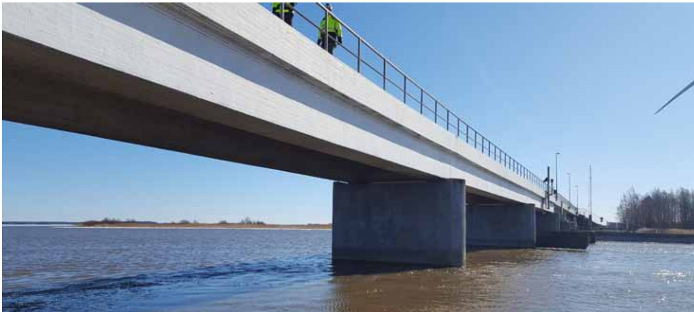
Kuva 5. Sillan betoniset jänteet.
