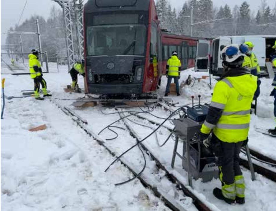
Raitiovaunun kiskoille palautus sivusiirtotekniikkaa hyödyntäen.
