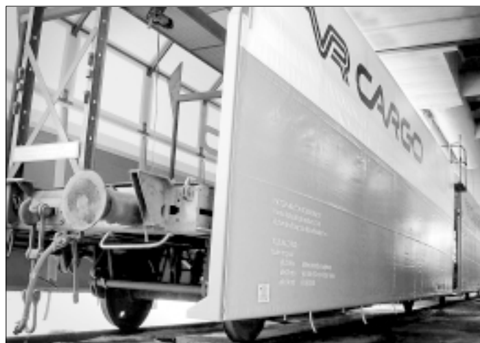
Katepressujen asennusvaunu. Katteiden pressujen asennus tapahtuu erillisen vaunun päällä, johon katerungot nostetaan kokoonpanosta. Kun puhallus ja maalaus tehdään saman vaunun päällä, tapahtuu katteen seuraava nosto suoraan Habbin -vaunuun, pressut asennettuna.
