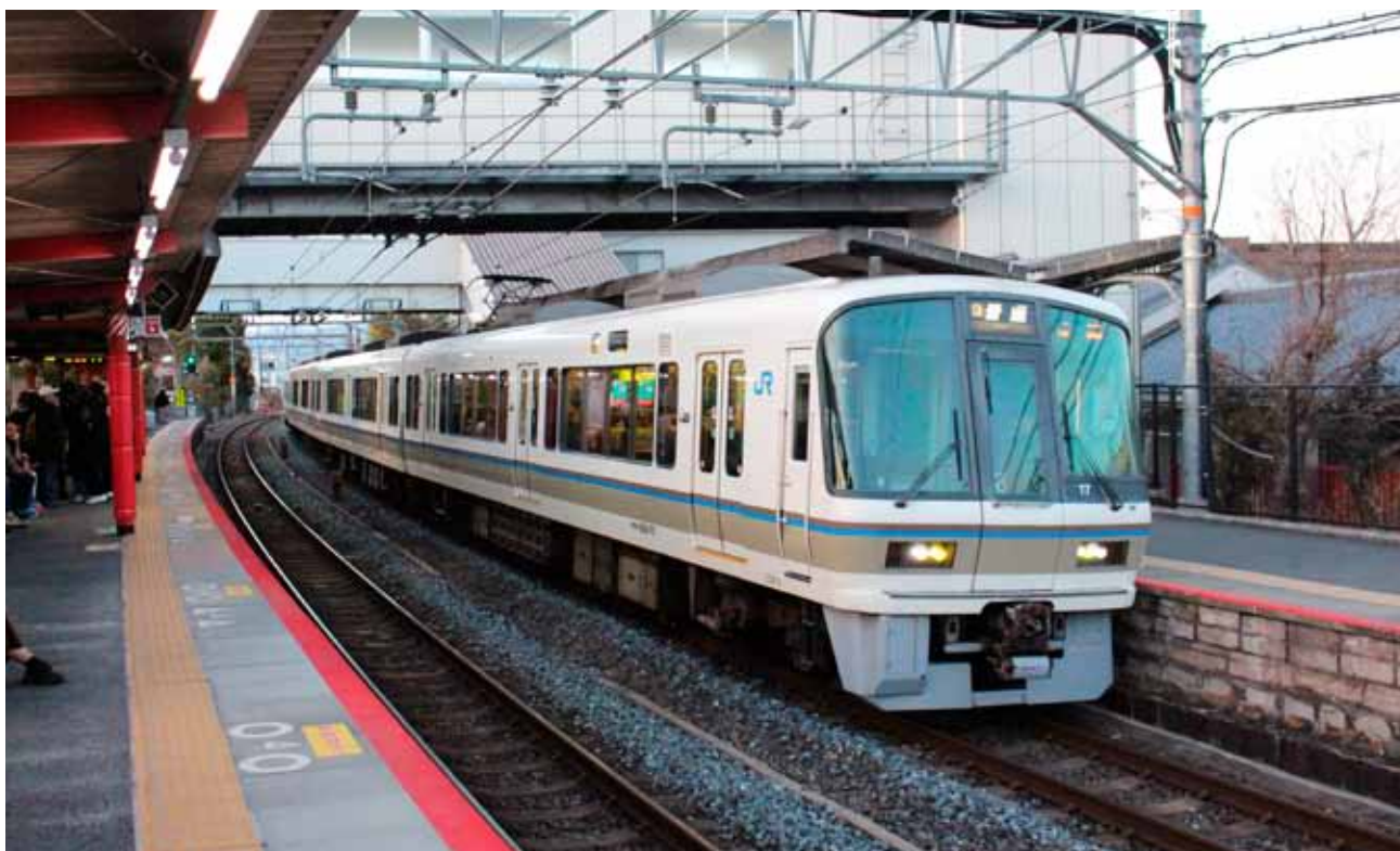
Punainen 20 cm turvaväritys laiturin reunassa; tämä kuva on otettu hämärässä, jolloin silloinkin erottuvuus oli hyvä.
