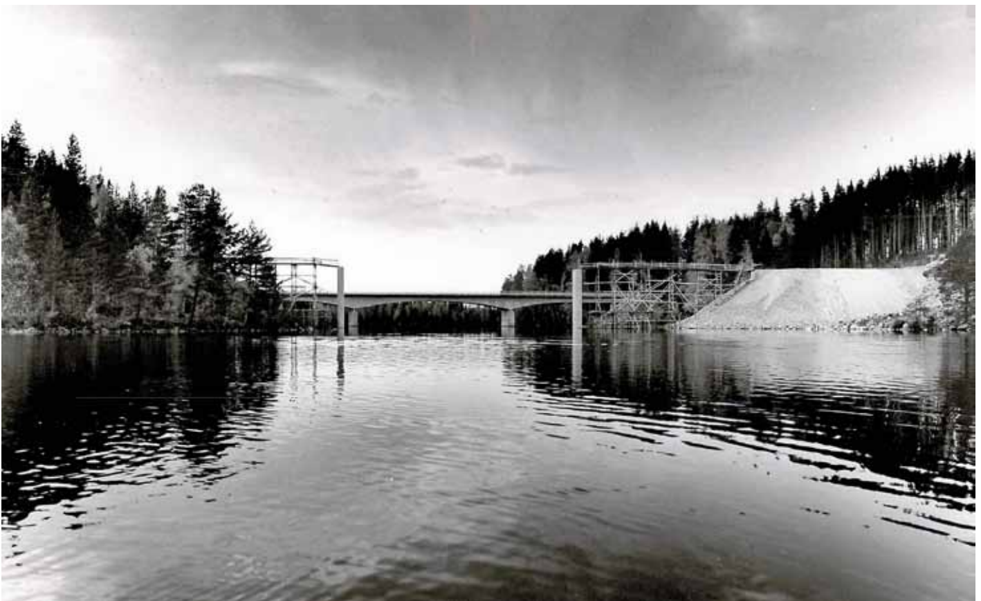
Kuva 2. Sillan rakentaminen käynnissä vuonna 1966.
