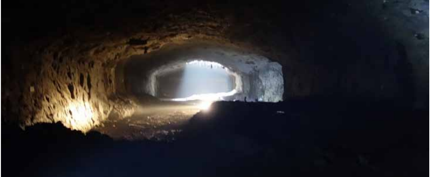
Kuva 5. Louhittu kalliotila. Kuva Kalle Hollmén, Sito Oy.
