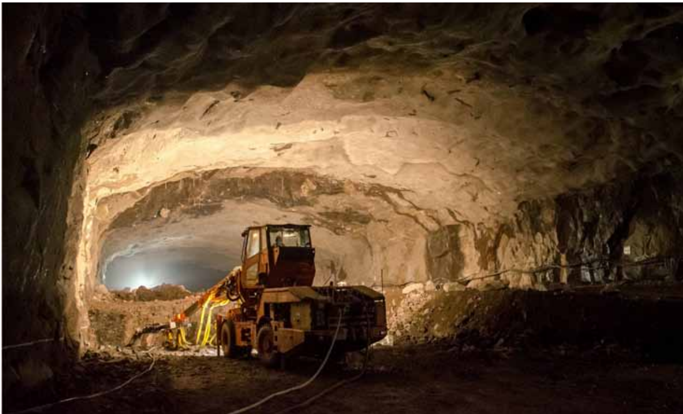
Kuva 4. Louhinta käynnissä. Kuva Minna Alantie, Louhintakonsultit Oy.
