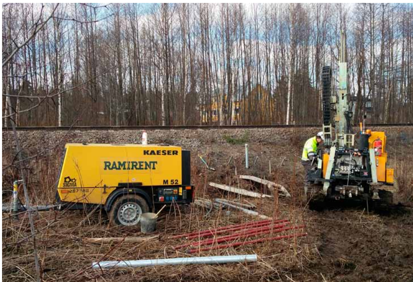
Kuva 1. Pohjatutkimukset käynnissä Kouvola–Kotka-rataosalla. Kuva: Antti Pelho.
