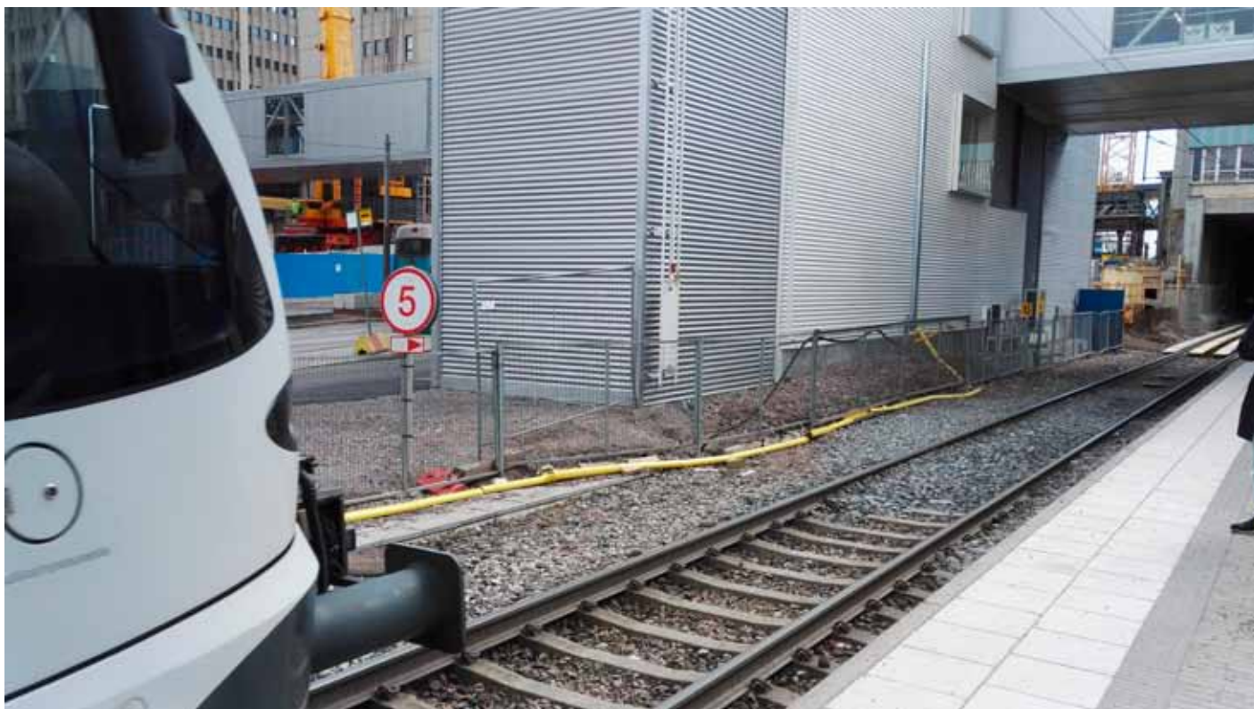
Kuva 2 Pasilan aseman kohdalla olevan työmaan nopeusrajoitus (Kuva: Tero Savolainen)
