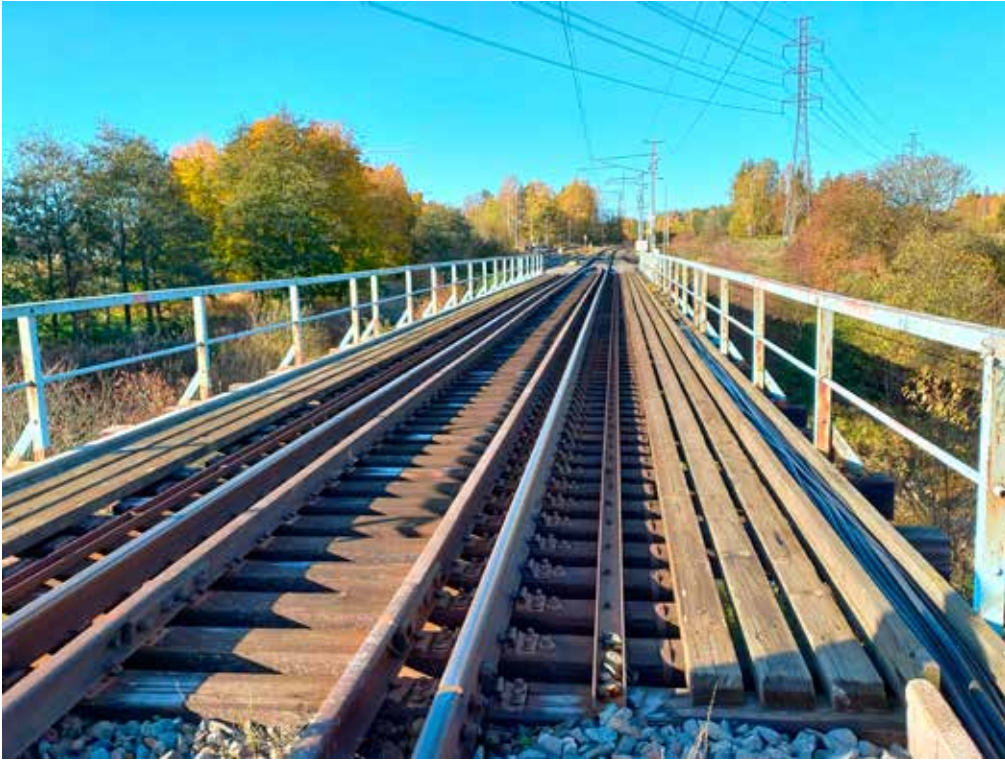
Sillalla päällysrakenne on melko hyvässä kunnossa, vaikka vaihde sillan länsipäässä tuo omat mausteensa siltapaikkaan.
