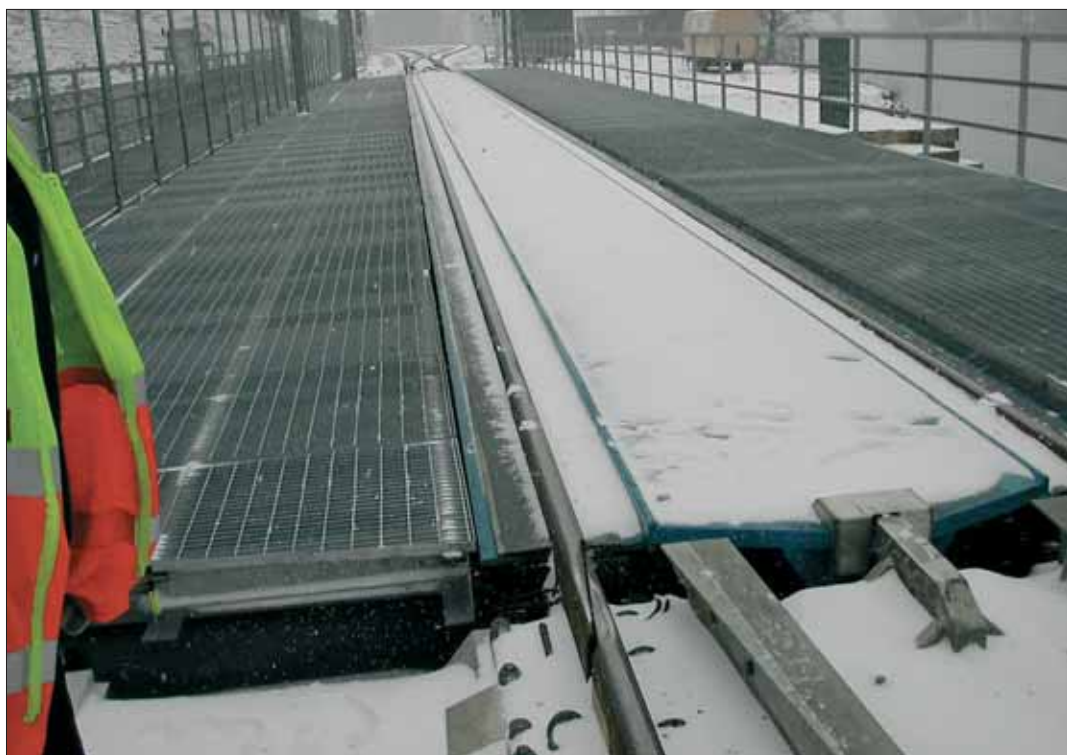
Köpmannebro, rakennettu v. 2001.
