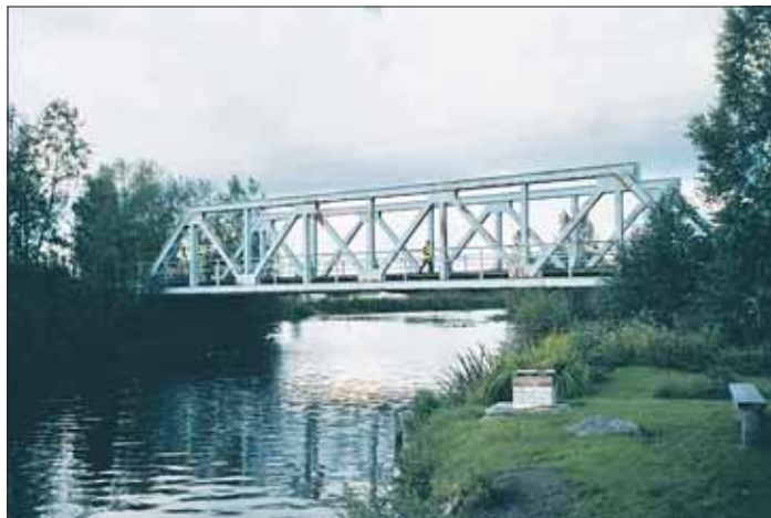
Ähtävänjoen ratasilta rakennettu v. 1938.
