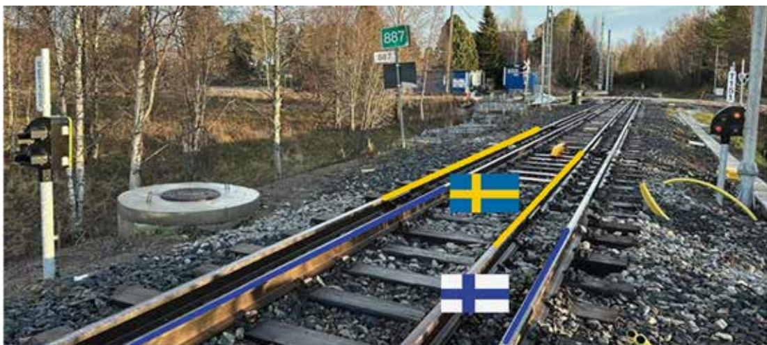
Kuva 3. Maastossa, raideopastimien T151 ja SET152 kohdalla oleva nelikiskoraide. Kuvassa vasemmalla puolella oleva raideopastin SET152 koskee Ruotsin raideleveyden raidetta ja oikealla puolella oleva raideopastin T151 Suomen raideleveyden raidetta. Kuva: Väylävirasto.
