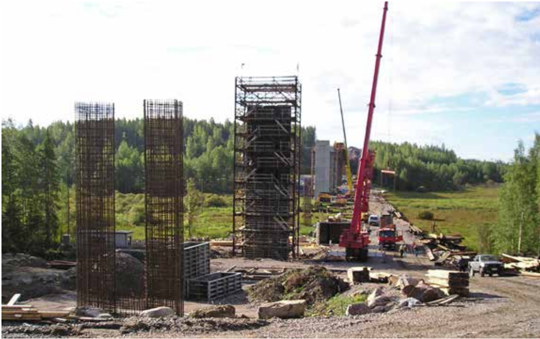
Kuva 2. Sillan rakentamista varten oli työmaatie ja työmaasilta Porvoonjoen yli.
