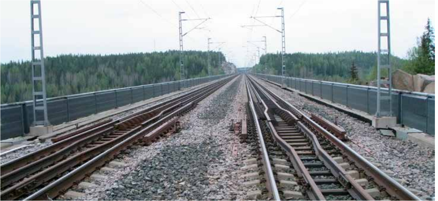
Kuva 4. Ratarakenteet sillalla.
