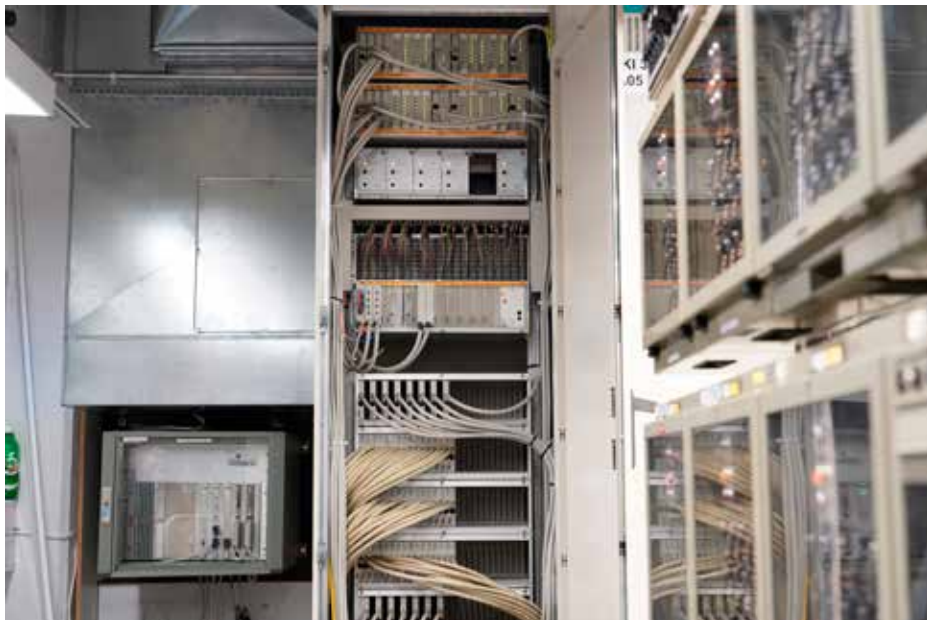
Kuva 4. EBILoop-silmukkatietokone ja Koppelrechner-liityntätietokone SpDrS60-VR-releryhmäasetinlaitteeseen kytkettynä
