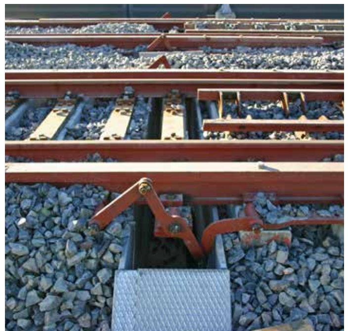
Kuva 3. Tukikerroksen katkaisulaite sillan eteläpäässä.
