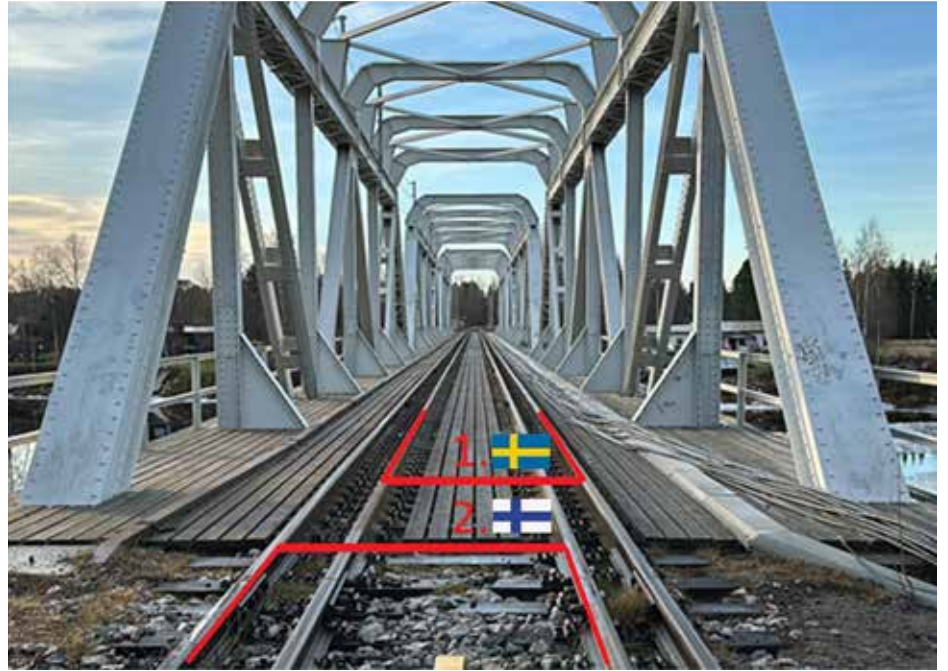
Kuva 2. Numerolla 1 on esitetty Ruotsin ja numerolla 2 Suomen rataverkon raideleveydellä oleva raide. Kuva: Väylävirasto.
