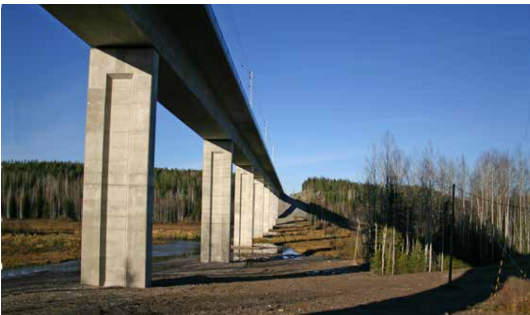
Kuva 5. Valmistuessaan silta ilta-auringossa.
