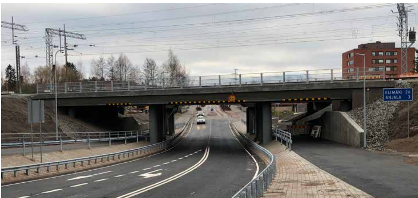
Kuva 8. Valmis itäpuolen silta (Kuva Pekka Lindqvist).
