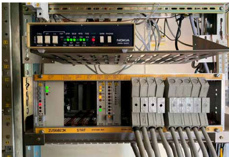
Kuva 1. Juurikorven ZUS-ala-asema. Yllä modeemi, jonka välityksellä dataliikennöinti Inkeröisten keskuksen tapahtuu. Alla korttikehikko.
