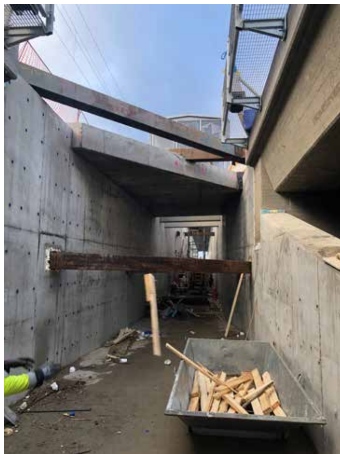
Kuva 5. Siltojen väliin tuleva luiska valmistumassa (Kuva Pekka Lindqvist).
