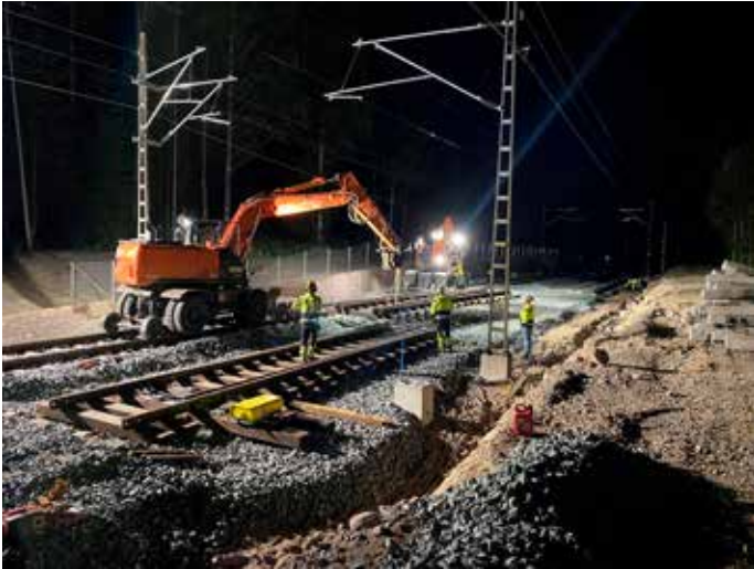
Kuva 7. Haminan raiteen tilapäisen VV54-1:9-vaihteen asennus käynnissä Juurikorvessa 7.8.2022.
