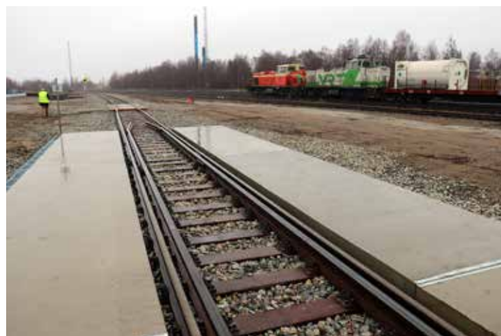
Telinvaihtoraiteen Suomen puolen pää, mistä raide jatkuu normaalina 1524 mm:n raiteena.
