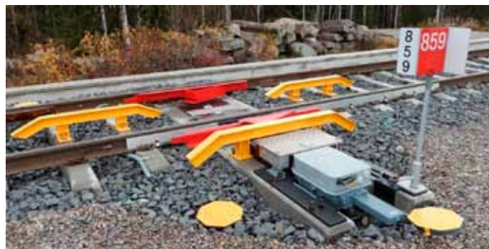
Pysäytinlaite perinteisellä kääntölaitteella Kontiomäellä. Kuva Tero Savolainen
