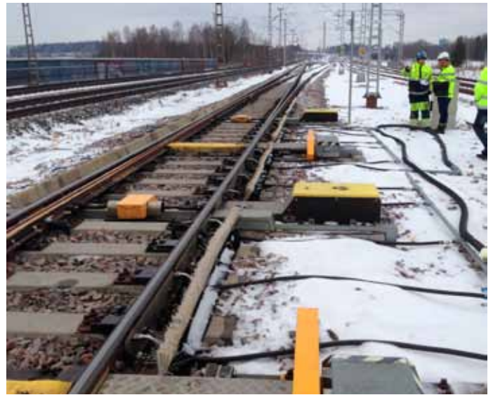
Kuva 4. Paineilemaputkisto asennettuna valmiiksi vaihteeseen 210. Osa putkistosta on asennettu maan päälle (kuvassa vaihteen etujatkoksesta katsottuna oikea puoli) ja osa on asennettu maan alle (vaihteen vasen puoli).
