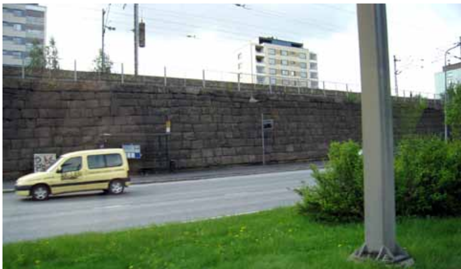
Kuva 3. Sillan jatkeena pohjoiseen oleva kivitukimuuri.
