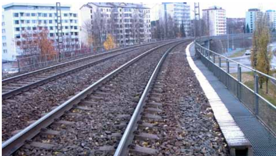
Silta on kaarteessa ja sepeliä on paljon ja on työmaana erittäin vaikea.
