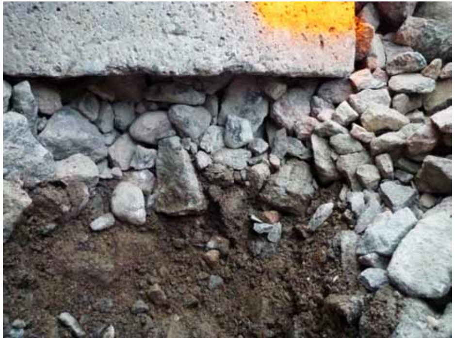
Hienontunutta raidesepeliä rantaradan koekohteesta. Kuva Ossi Peltokangas 2014.
