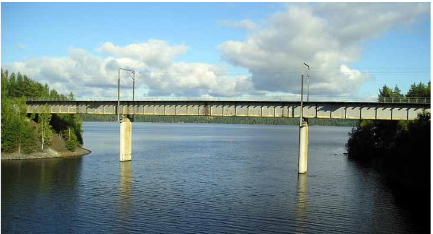
Syrjäsalmen ratasillan monitorointi Kiteellä on käynnissä parhaillaan.
