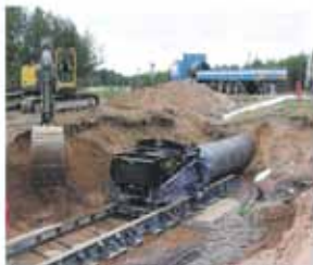
Työntöporasta American Augers 72-1200NG koneella, DN1600 asennus.
