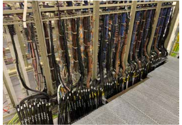
Kuva 5. Asetinlaitteen vaatimat runkokaapelit vedetty laitettiin ja päätetty asetinlaitteen ristikytkentätelineeseen.
