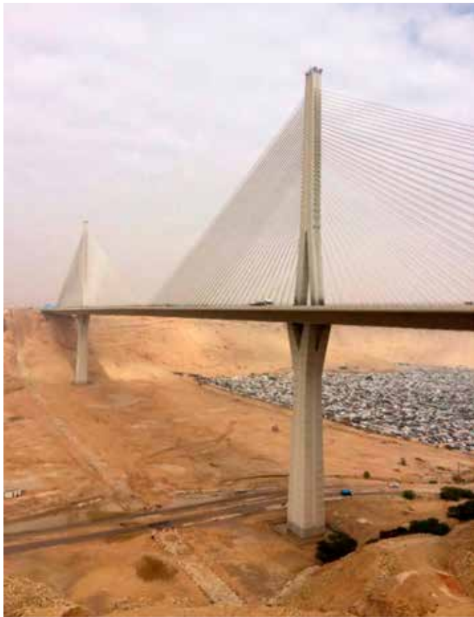
Kuva 1. Wadi Leban Bridge, Riyadh, kuva Reed Ellis esityksestä "Implementation of bridge management in the Kingdom of Saudi Arabia".
