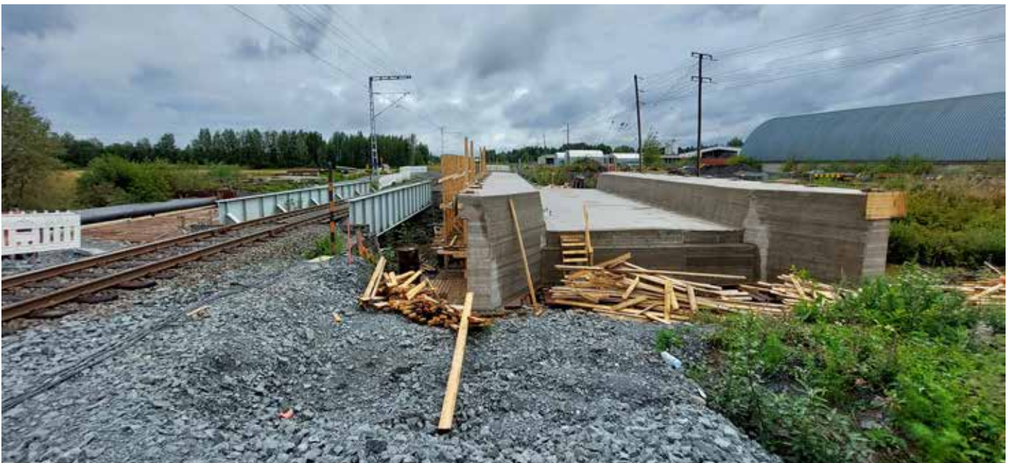
Kuvan kivirumpu uusitaan teräsrummuksi.
