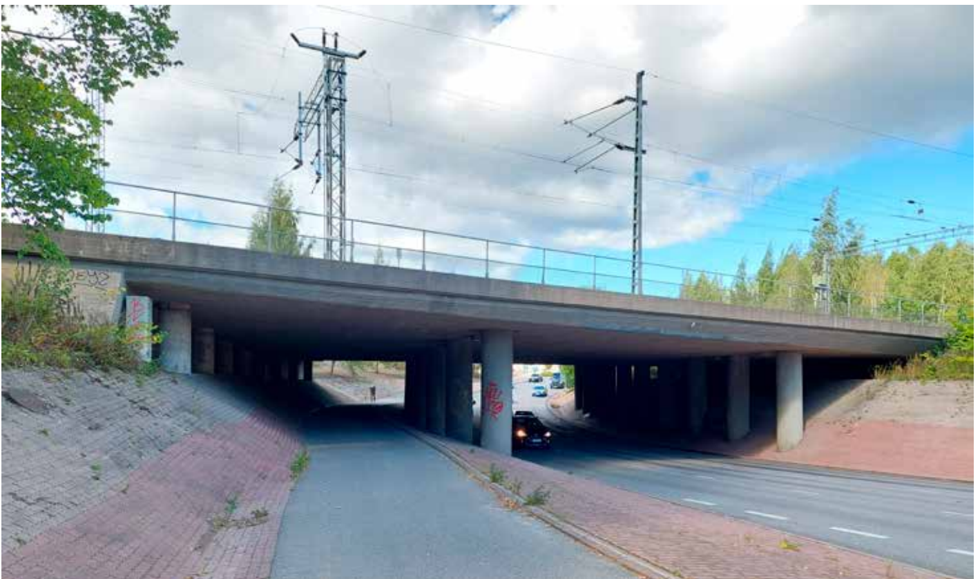
Kuva 6. Vuonna 1991 valmistunut Puistokadun alikulkusiltapaikalla asfaltin ja kivetysten alla paljon kaupunkitekniikkaa ja mm. kallioankkurein sidottu pohjalaatta.
