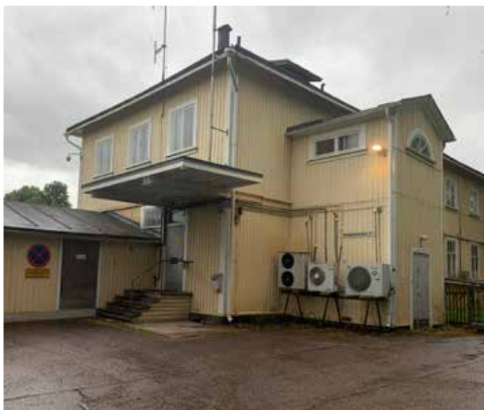
Kuva 1. Vanha asetinlaiterakennus, jossa korvattava releasetinlaite on ollut vuodesta 1991.
