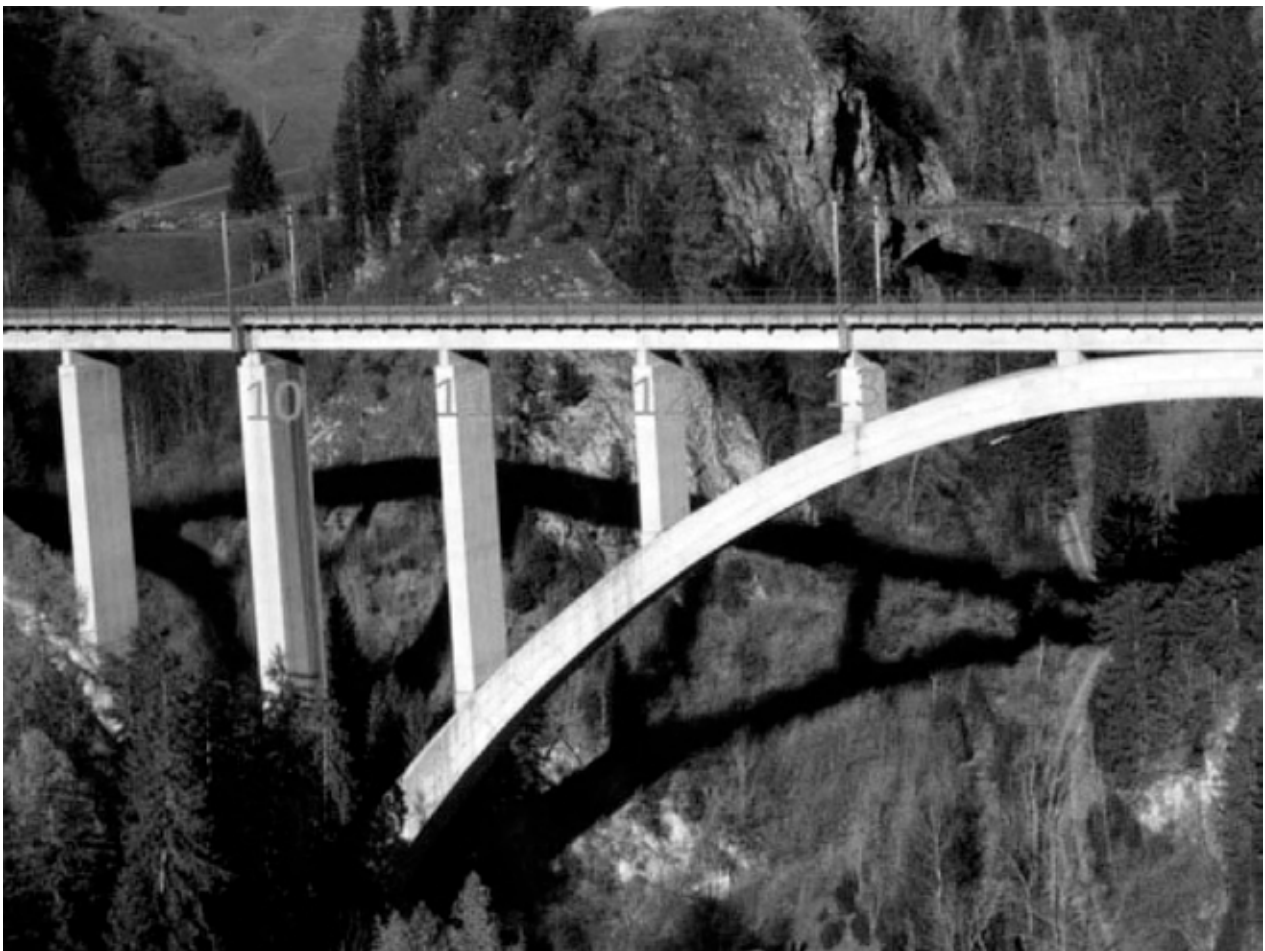
Kuva 3. Falkensteinbrücke Itävallassa, kuva P. Furrnerin esityksestä “Automated infrastructure inspection based on digital twins and machine learning”.
