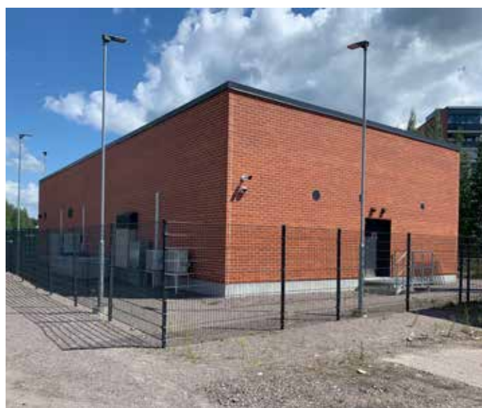
Kuva 2. Valmistunut laitetilarakennus uudelle asetinlaitteelle.
