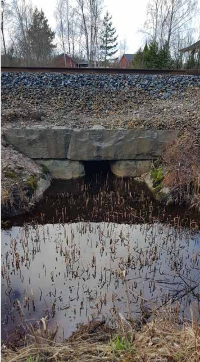
Kuvan kivirumpu uusitaan teräsrummuksi.
