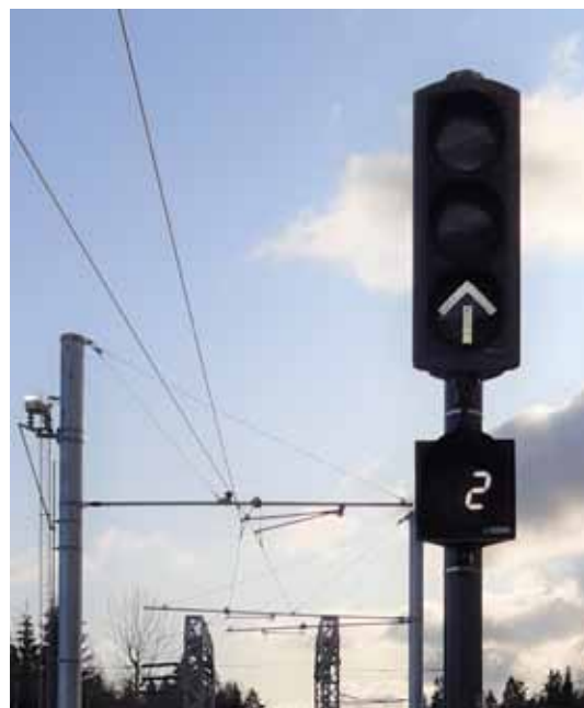
Kuva 2. Kulkutie varmistettu raiteelle 2.
