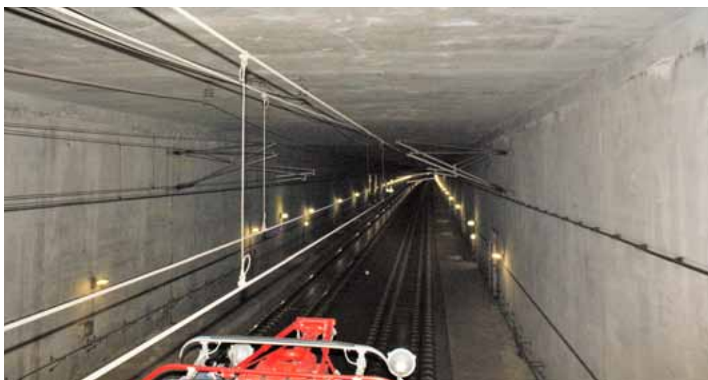
Kuva 2. Pääsimme tutkimaan Re330-ratajohdon rakennetta myös lähempää DB Netzin huoltovaunulla Offenbau-tunnelissa. Kuva: Sami Paldanius.
